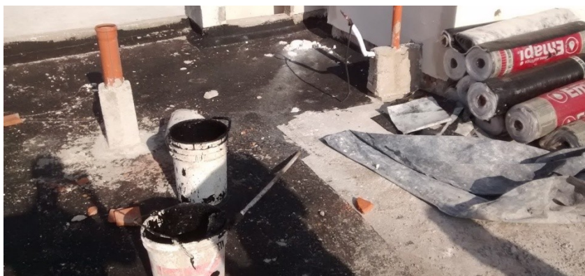
Figura 36: superficie de la azotea pintada con asfalto, recipientes con pintura asfáltica y el rodillo empleado para realizar la imprimación.
