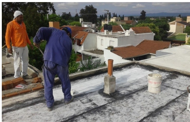
Figura 40: dos manos a rodillo a la membrana con
