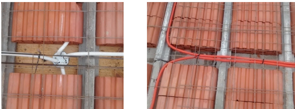
Figura 27: caños corrugados y boca de techo de la instalación eléctrica.
