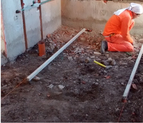
Figura 48: oficial albañil colocando las guías o reglas en la cota correcta, previamente demarco el
