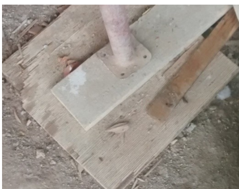
Figura 22: tablas de 20x20 cm, para evitar el punzonado del
