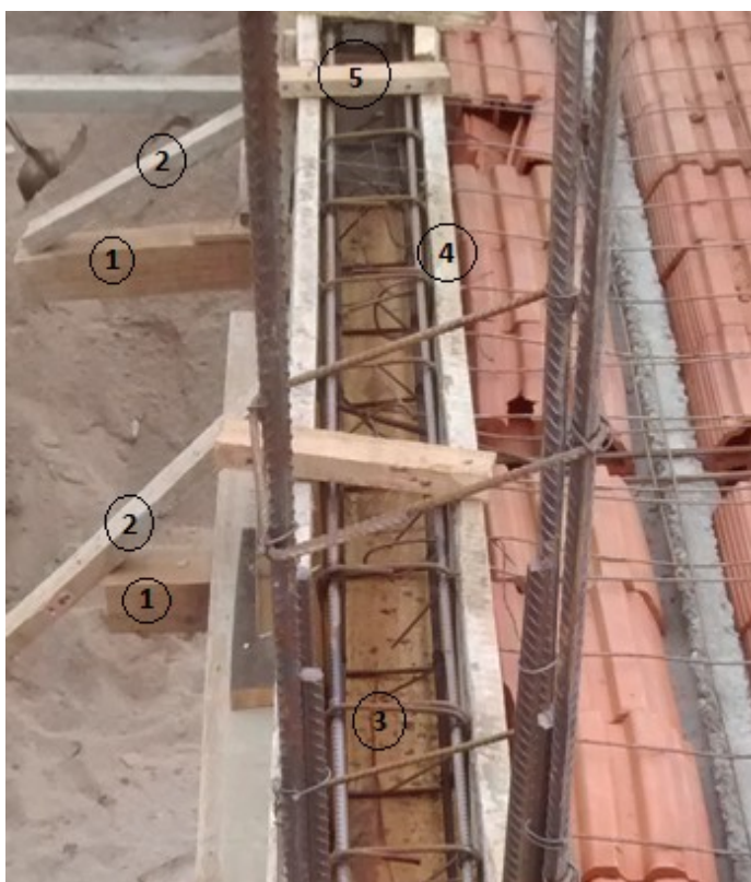
Figura 26: Encofrado de madera para viga de encadenado:
