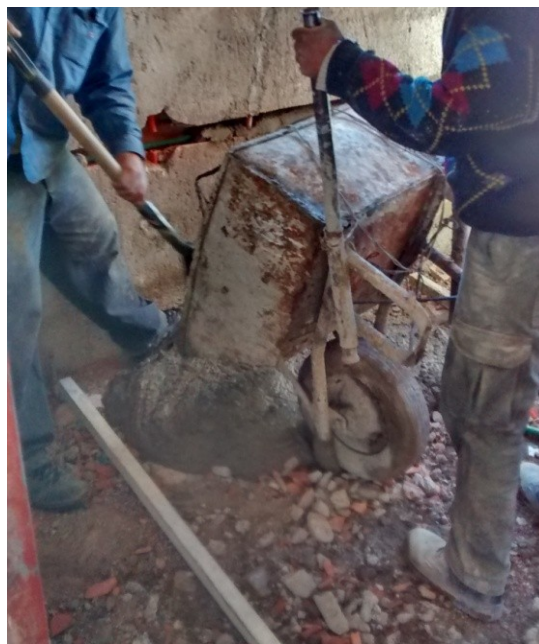
Figura 48: colado del Hº
