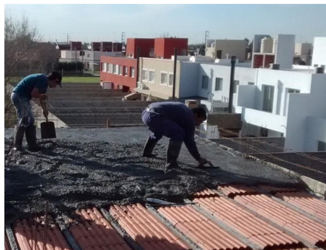
Figura 31: distribución del Hº y emparejado de la superficie.
