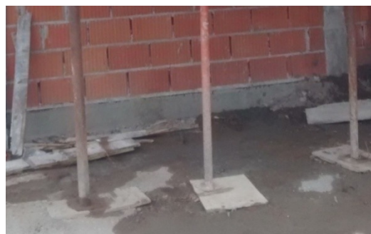
Figura 23: 1-Puntales metálicos cada 90 cm. 2- Soleras de 3"x3".
