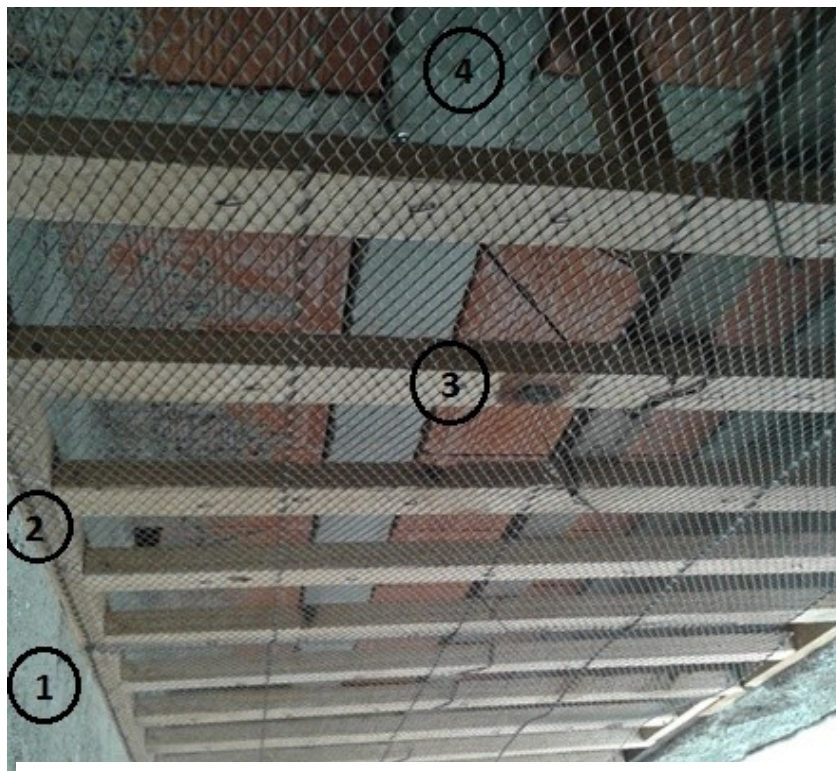
Figura 60: estructura de cielorraso armado independiente:
