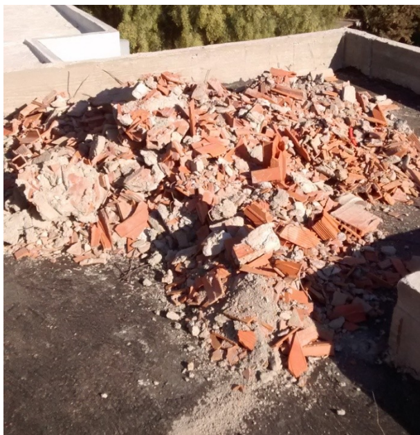
Figura 35: escombros empleados para el relleno con
