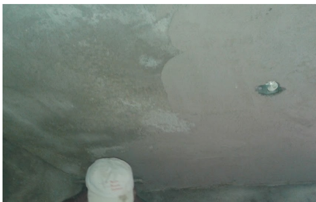
Figura 62: albañil aplicando el mortero con el fratacho en el cielorraso aplicado
