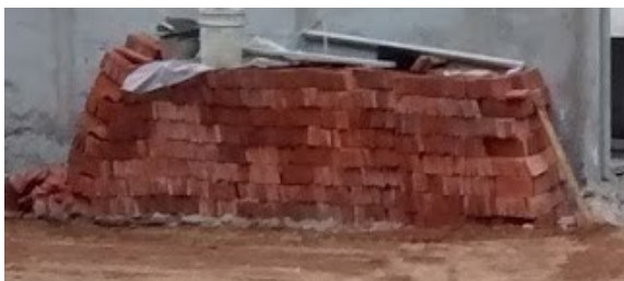
Figura 41: acopio de bovedillas sobre el terreno.
