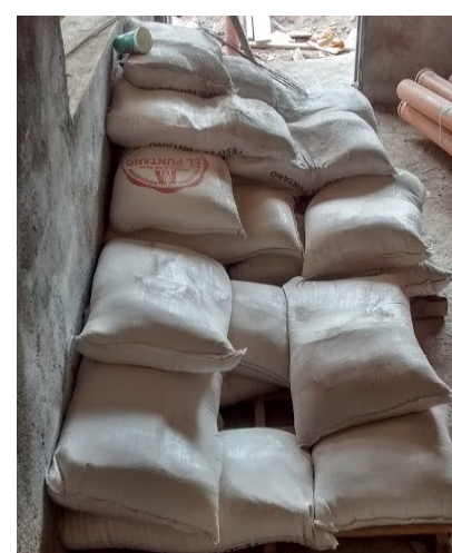
Figura 17: acopio bajo techo de bolsas de cemento de albañilería (imagen de la izquierda), de pegamento cerámico (central) y yeso (derecha).
