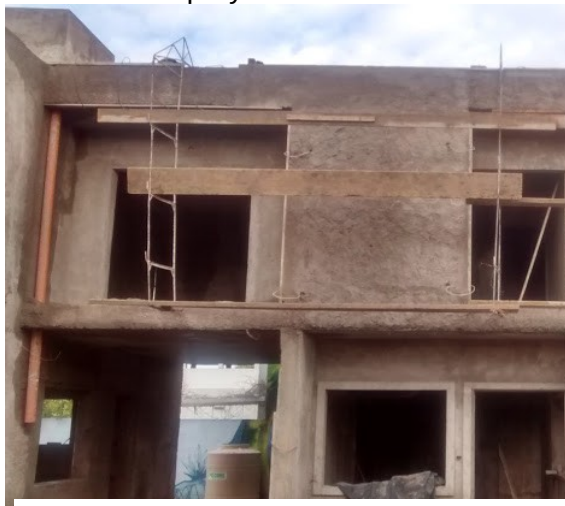
Figura 50: andamio en voladizo durante la ejecución del azotado impermeable
