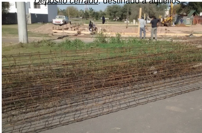
Figura 15: el acopio de armadura para pilotes, se realizó en un lote vecino, evitando entorpecer las tareas en la zona de obra. Las barras de acero se encontraban clasificadas por diámetros
