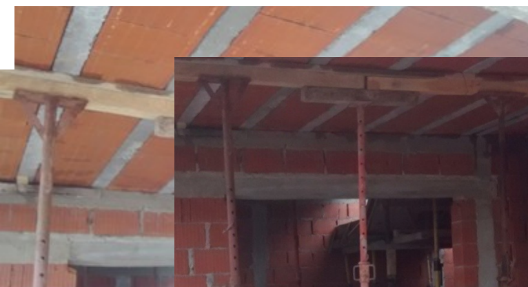
Figura 23: 1-Puntales metálicos cada 90 cm. 2- Soleras de 3"x3".
