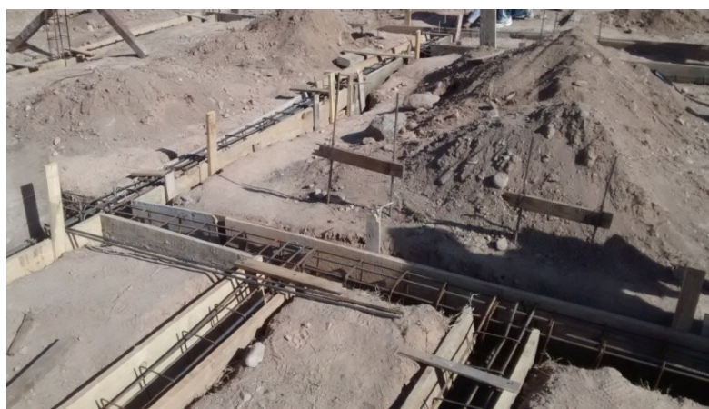
Figura 20: excavación de viga de fundación, con su encofrado y su armadura.
