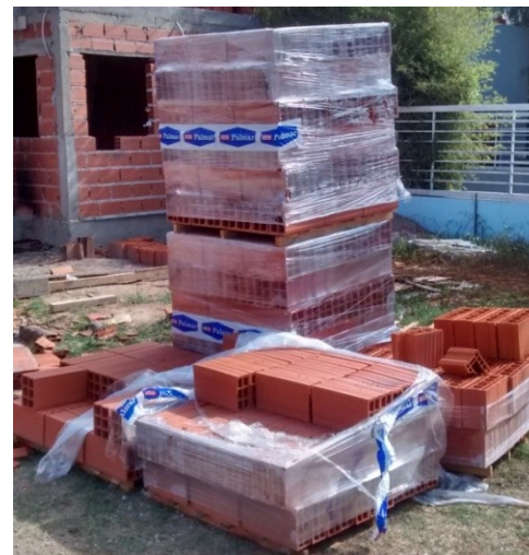
Figura 16: almacenaje de ladrillos cerámicos zona de materiales que debían ser
