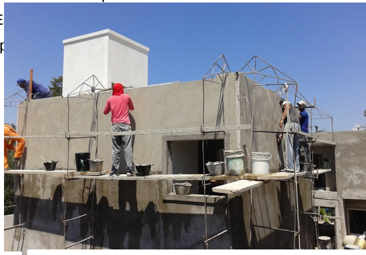
Figura 51: andamio en voladizo durante la ejecución del enlucido.
