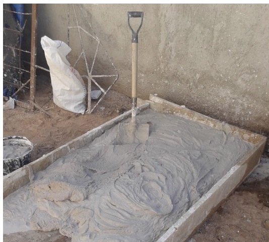
Figura 54: "cachimbo" de madera con mezcla para enlucido.
