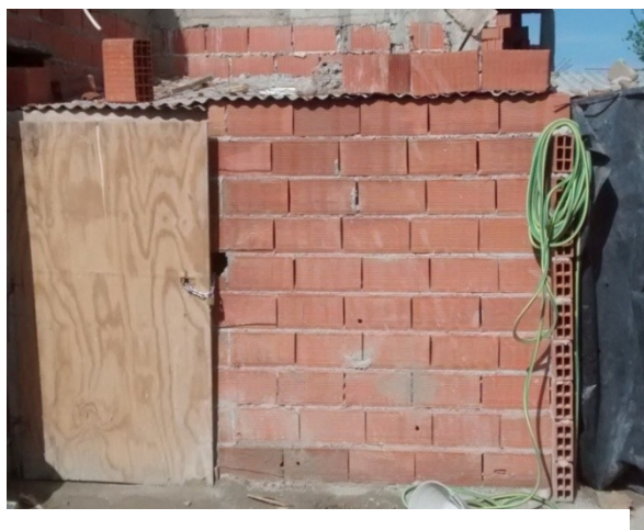
Figura 7: depósito cerrado de ladrillo cerámico y techo de chapa
