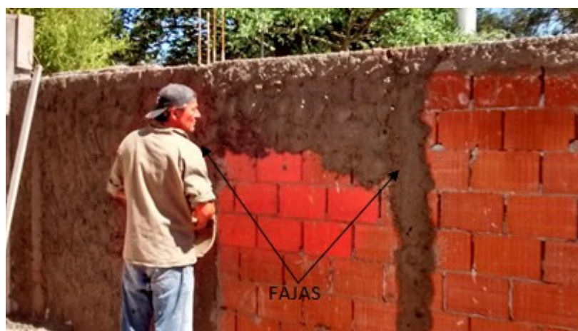
Figura 52: azotado hidrófugo de la tapia.
