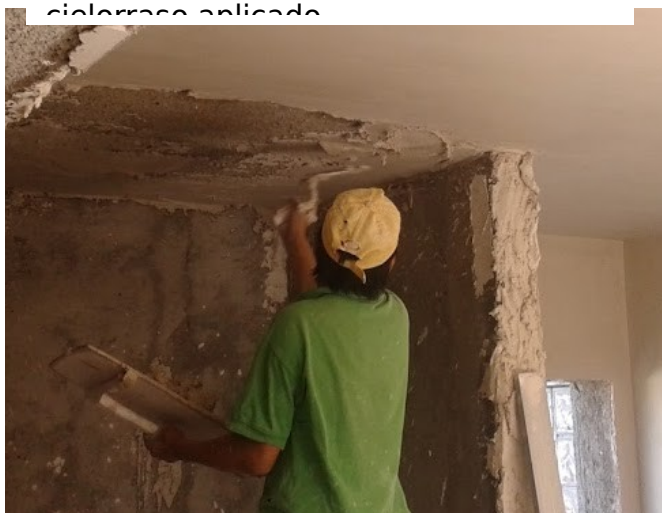
Figuras 64-65: yesero realizando el engrose con yeso negro en el cielorraso. Para esta tarea se lanza con fuerza capas finas de pasta con cuchara y luego se empareja con la regla.
