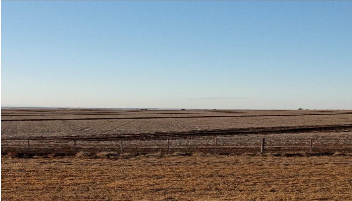
Fotografía 4. Sistematización de un lote cercano a Monte Ralo
