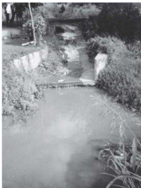
Figura 17: Situación típica de descarga de canales de escurrimiento superficial sobre el canal de riego.
