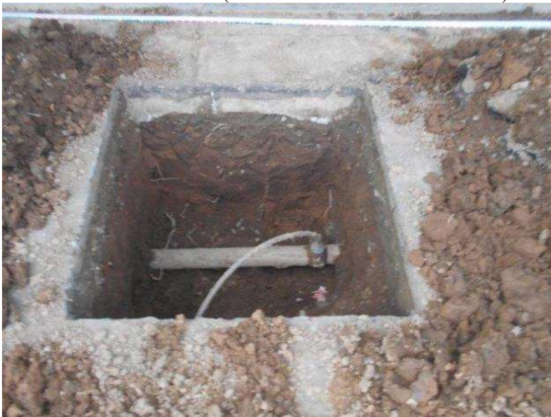
Excavación en vereda (conexión domiciliar descubierta)
