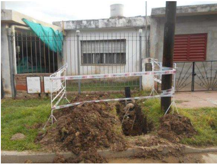
Excavación en vereda (conexión domiciliar descubierta)
