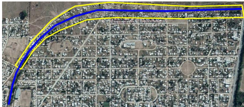
Figura 3.3: Canal de desagüe pluvial que atraviesa el asentamiento.
