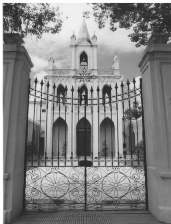
Inmueble contemplado en la ordenanza de preservación patrimonial N° 11.190/06 (Categoría media N° 108)
