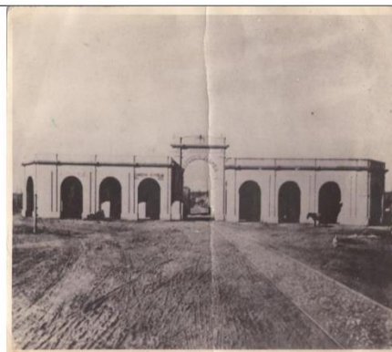
Imagen de la antigua fachada del ex Mercado Marcos Juárez.
