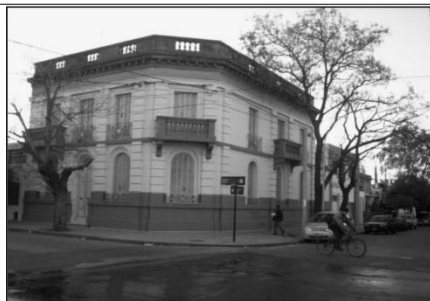
Inmueble contemplado en la ordenanza de preservación patrimonial N° 11.190/06 (Categoría media N° 101)
