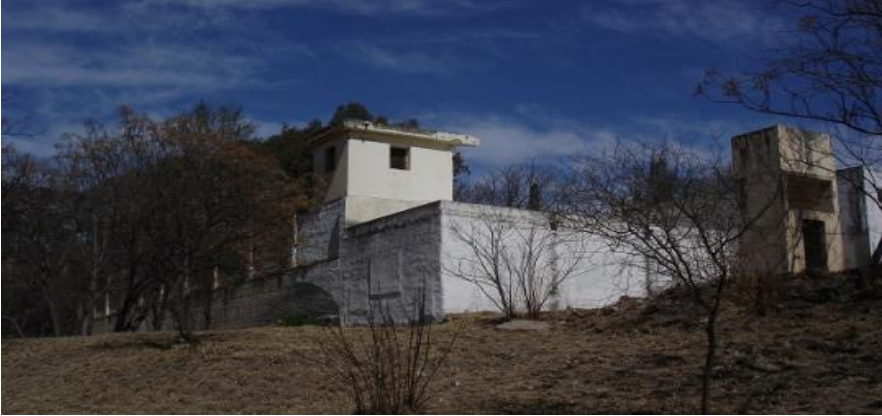
Figura 1. Vista actual externa del CCDTyE, sección conservada tal como fuera durante la última dictadura militar argentina. Recuperada de: http://www.apm.gov.ar/clar/sitio-hist%C3%B3rico
