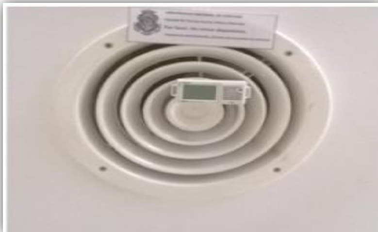
Figura 3-11. Hobo N°2 en Reja de Inyección de equipo PB+PA 2
