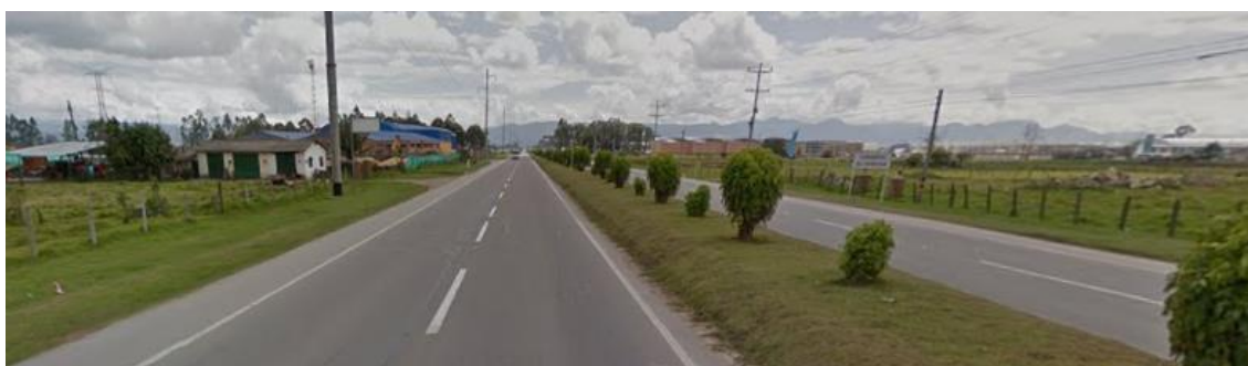
Figura 5.7. Tramo 2. Siberia- Puente Piedra
