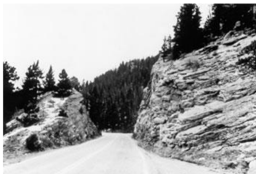
Figura 7.7. Ejemplo de vía con RHR=7
