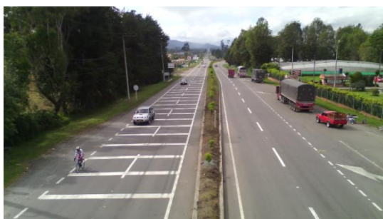
Figura 8.1. Tramo 3. Puente Piedra – Cruce Rosal
