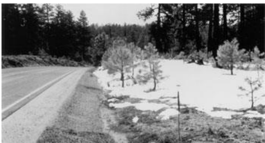
Figura 7.5. Ejemplo de vía con RHR=5
