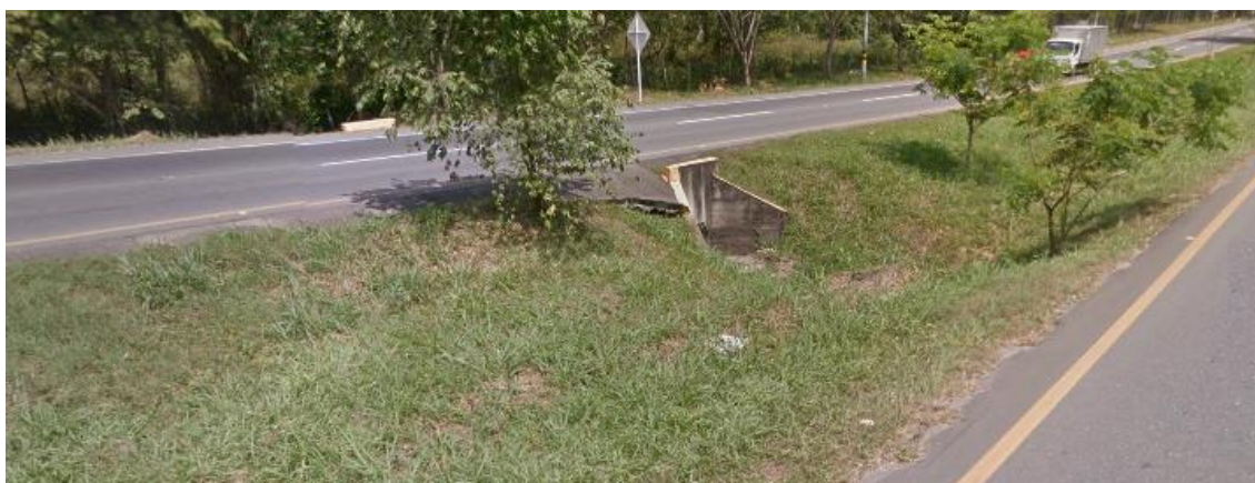
Figura 6.15. Cabezal de Alcantarilla en Separador Tramo Melgar-Ricaurte
