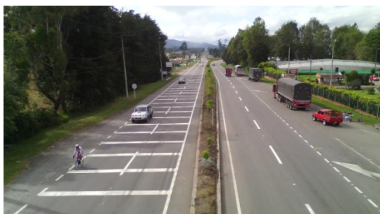
Figura 7.8. Tramo 3. Puente Piedra – Cruce Rosal
