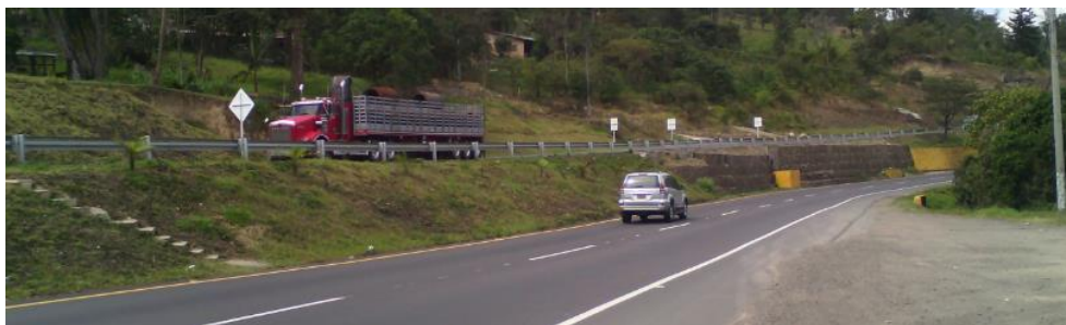
Figura 6.14. Separador Tramo T del Salto - Silvania
