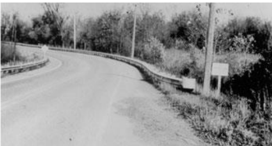
Figura 7.6. Ejemplo de vía con RHR=6
