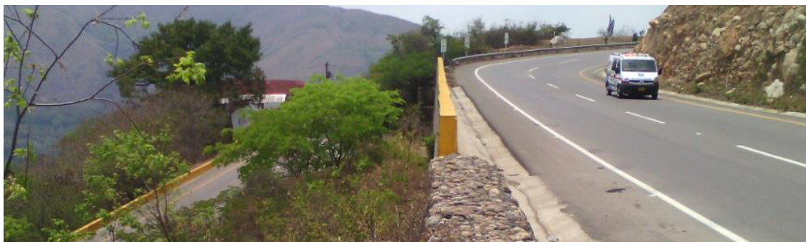
Figura 5.35. Tramo 15. Descenso Boquerón
