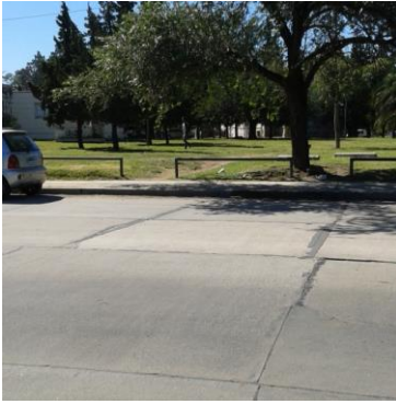
Se puede observar la salida del tramo independiente propuesto
