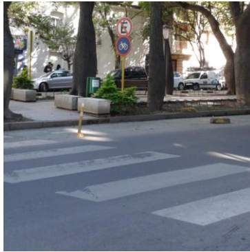
Se observa la señalización de la bicisenda. Señal de "circulación de bicicletas", señal de "prohibido estacionar", bastones reflectivos y bloques amarillos de hormigón para separar el bicicarril del resto de la calzada
