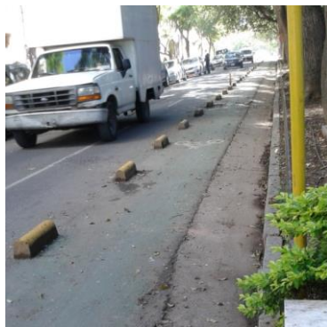
Se observa la pequeña separación existente entre bloque y bloque amarillo de hormigón
