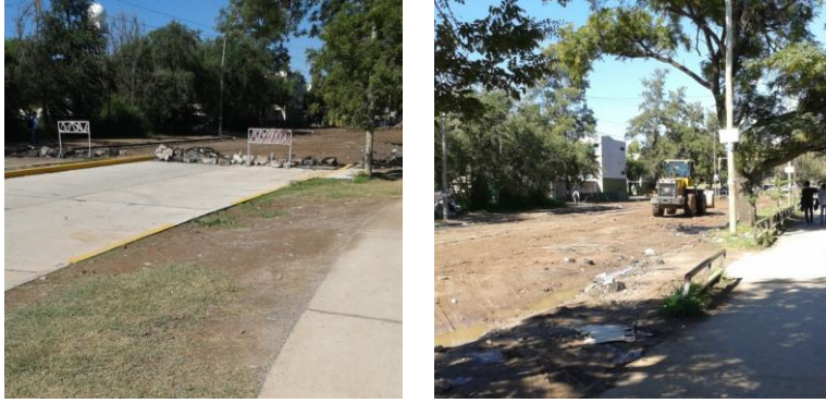
Calzada en reconstrucción
