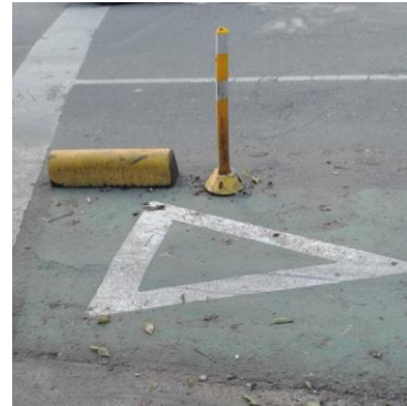
Vista en detalle de bastón reflectivo, bloque amarillo de hormigón y señalización sobre la bicisenda de "ceda el paso"
