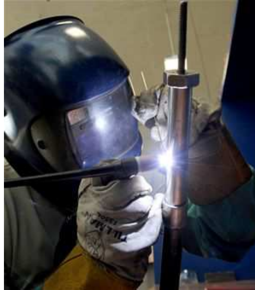
Figura 32: Reparación por soldadura TIG.
