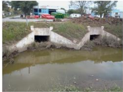
Alcantarilla Cura Brochero
