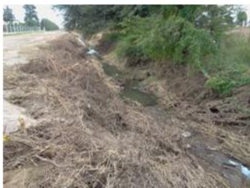
Canal paralelo al camino Norte
