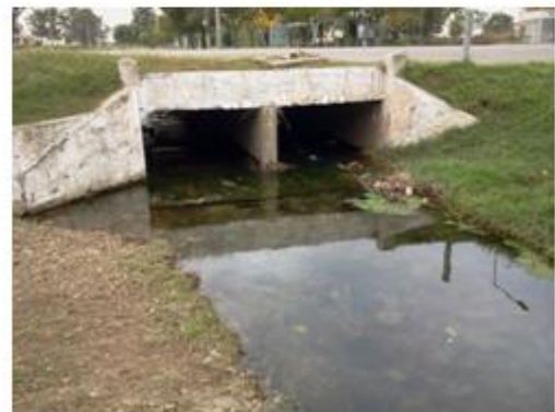
Cruce Canal Central - RP N° 13
