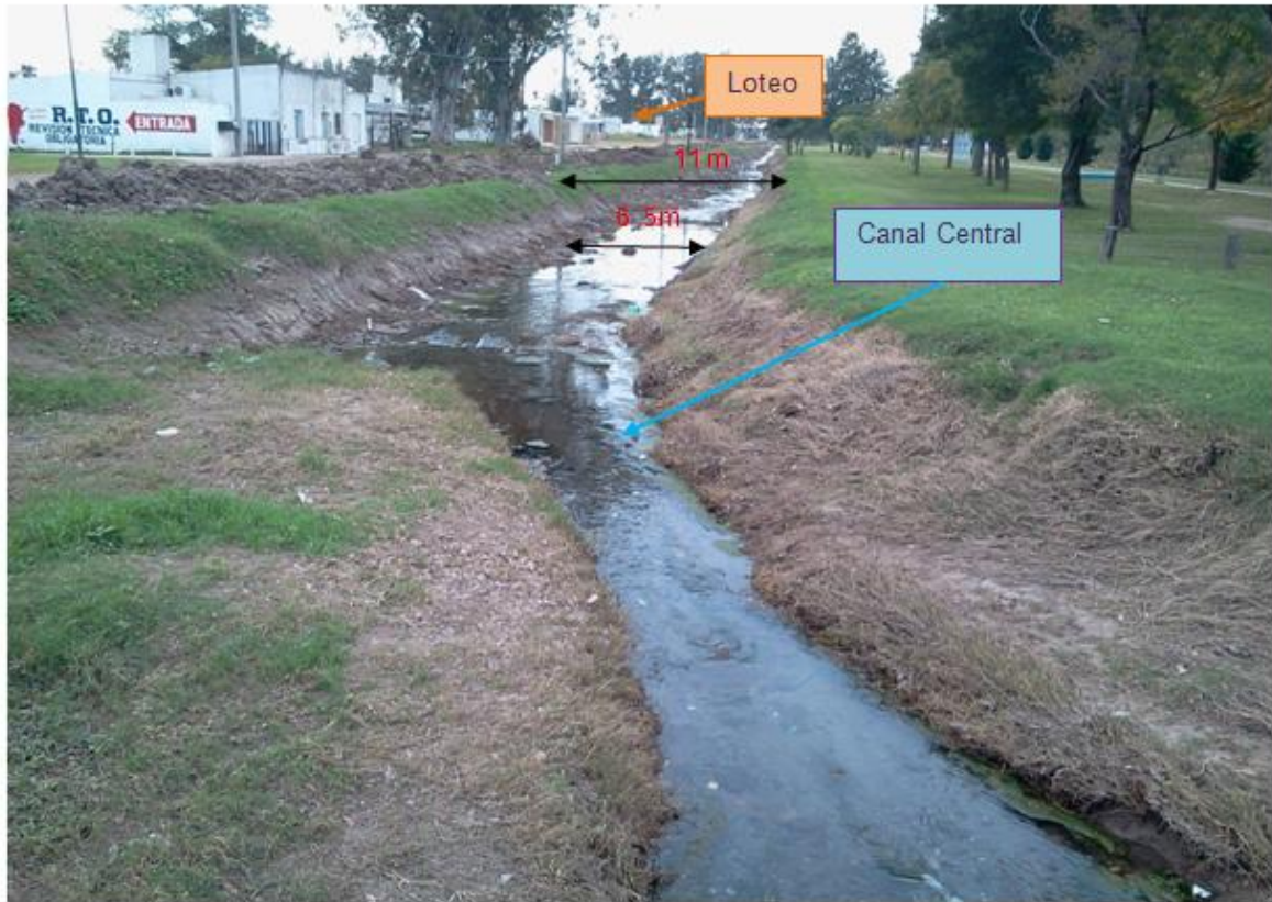
Figura 4-27. Canal Central Las Varillas (vista desde RP N°13).
