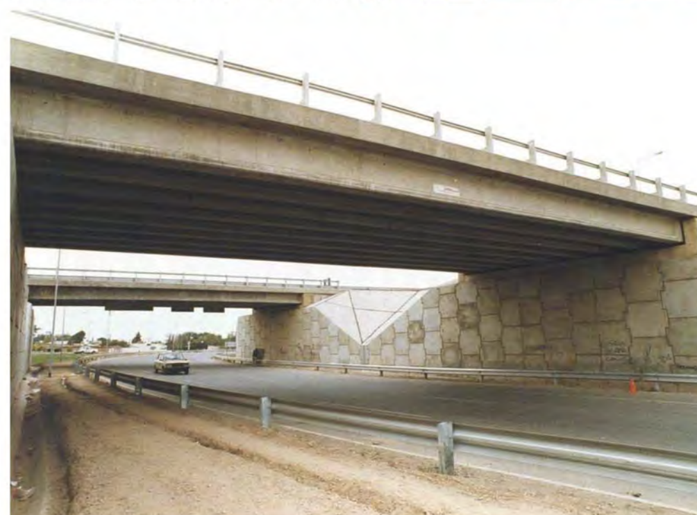
Sistema de puentes y pasarelas
