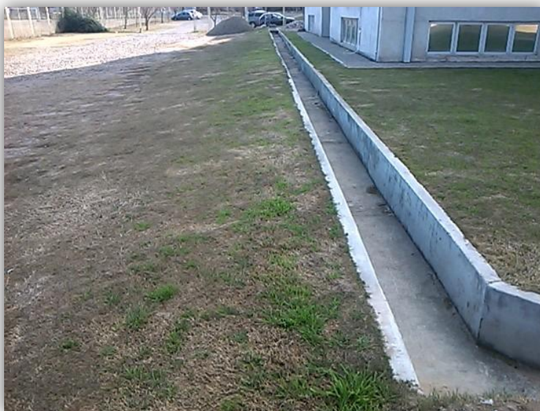
Fig. 5.11 Canal que rodea al edificio
