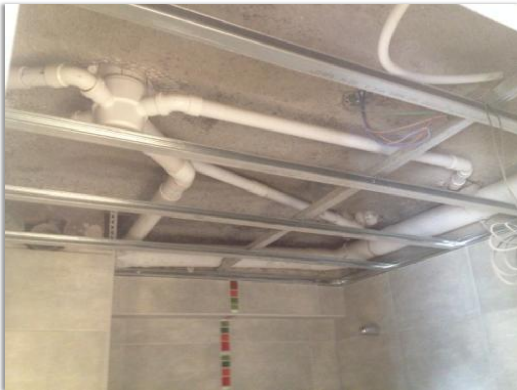
Esquema de Instalación Cloacal Primaria y Secundaria.
