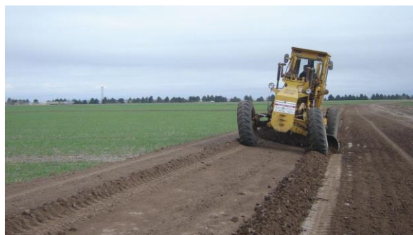
Figura N° 33: Construcción con motoniveladora.
