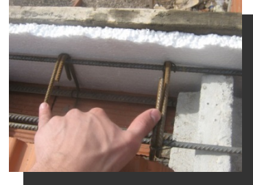
Fig.3: Colocación de Viguetas
