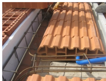
Fig. 5: Fijación cajas octog. de luz
