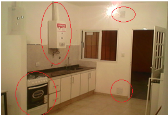
Fig. 16: Ubicación de artefactos a Gas y rejillas de ventilación
