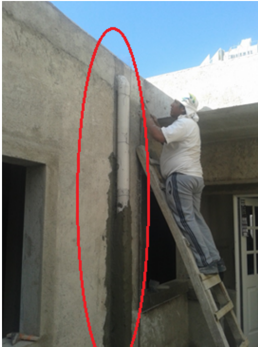
Fig. 8 Revestimiento de Bajadas Pluviales
