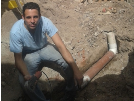
Fig. N°14 Excav. Zanjas para cañerías 110 mm.
