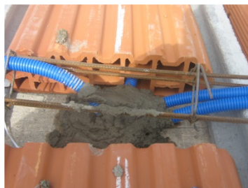
Fig. 4: tendido de red eléctrica
