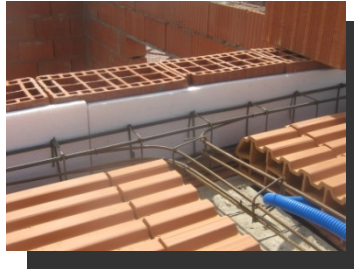
Fig.2: Prever libre dilación de losas
