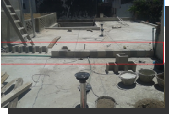
Fig. 9 Construcción de molduras p/ revestir
