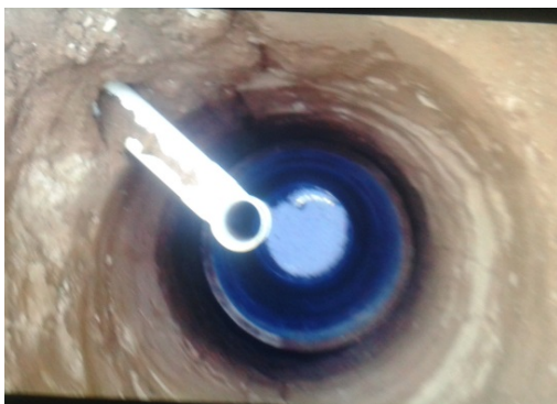
Fig. N°12 Excavación Pozo circular
