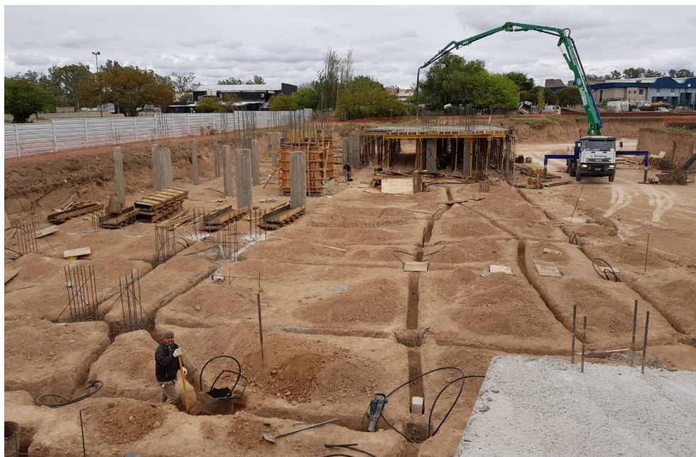
Figura 23. Proceso de implementación de las sondas geotérmicas en el Complejo Chateau Harmonie.
