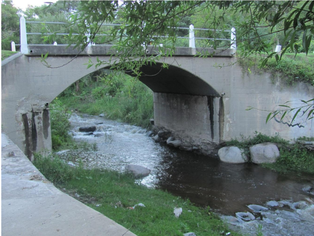
Figura 29. Estructura 2: Puente frente a juzgado de paz (vista hacia aguas arriba)
