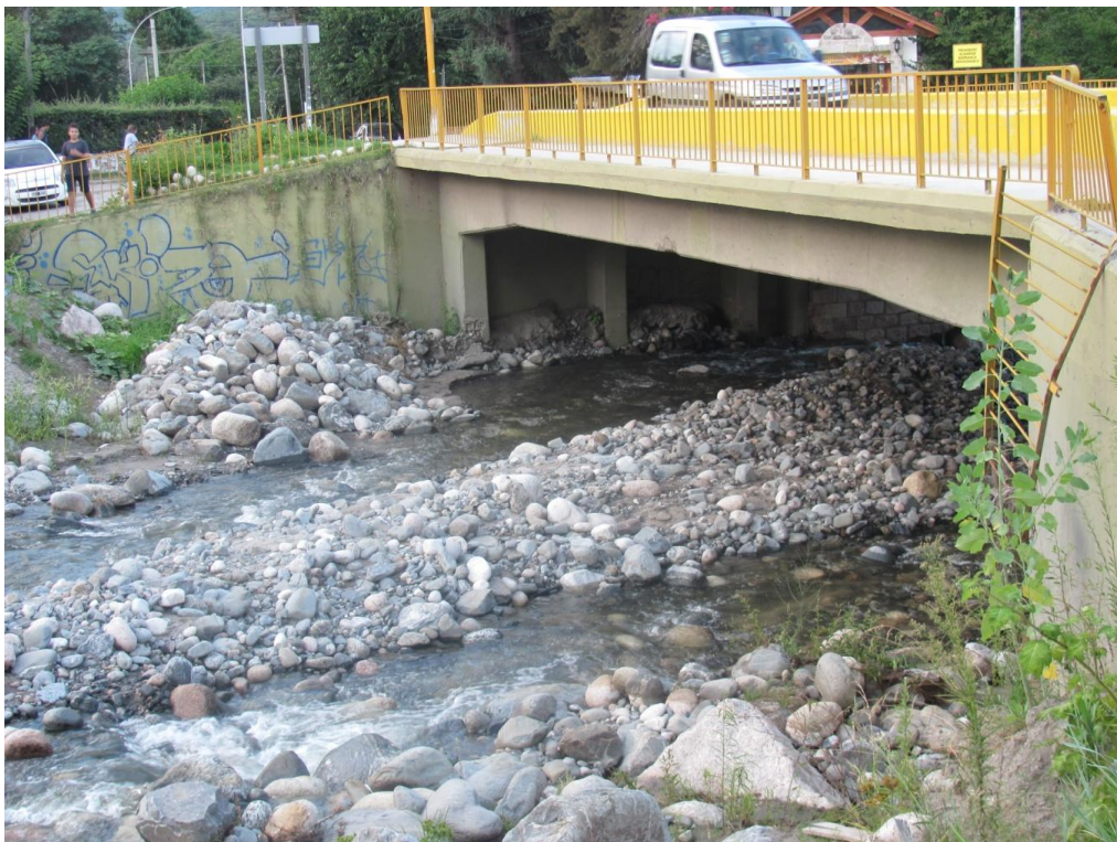
Figura 17. Vista cauce Ambato, aguas arriba del puente de ruta 4 (Estructura 3)
