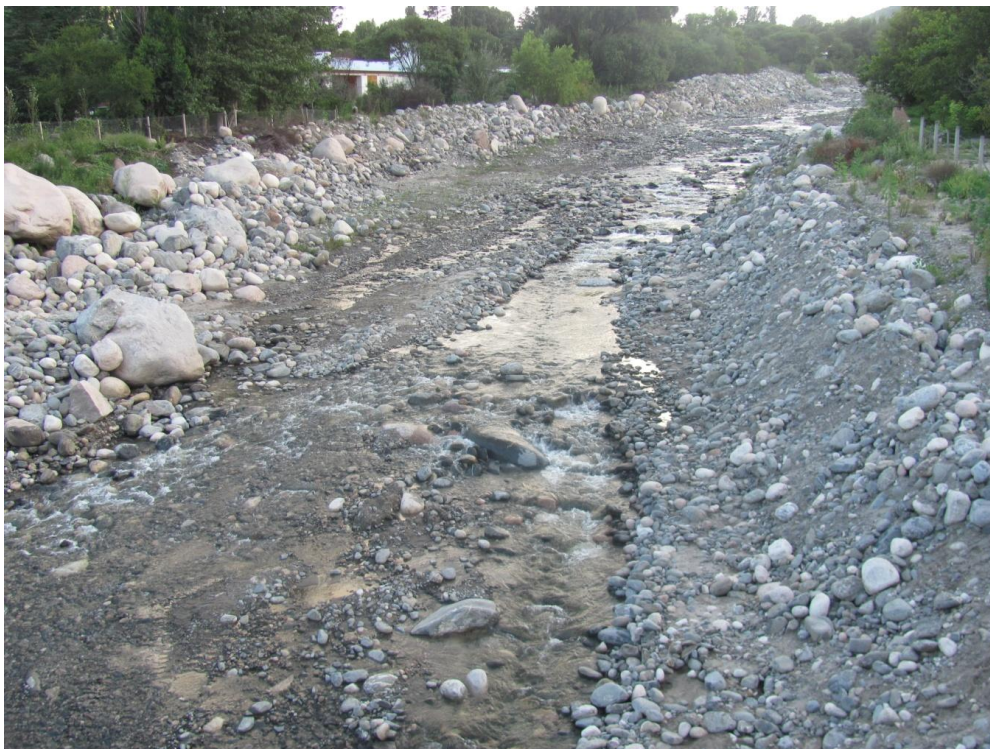
Figura 15. Vista del cauce de Ambato, aguas debajo de antiguo puente arco, próximo a la farmacia
