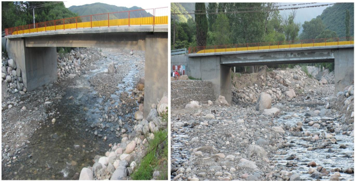
Figura 13. Estructura 1: Puente próximo a la policía. Vista hacia aguas abajo (izq.). Vista hacia aguas arriba (der.)
