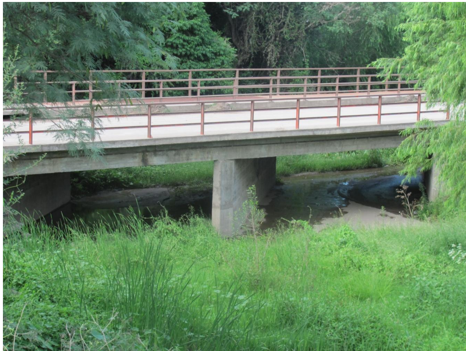
Figura 37. Estructura 2: Alcantarilla faldeo al Cristo (vista desde aguas arriba)
