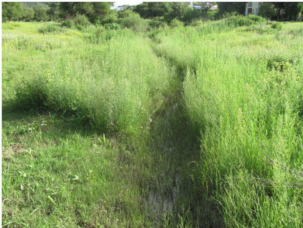
Figura 36. Cauce río Seco, aguas arriba de vado camino a polideportivo (Estructura 1).
