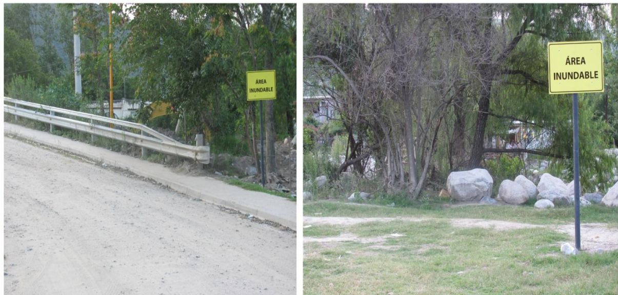
Figura 19. Carteles sobre puente próximo al mástil y a puente de ruta 4 sobre río Ambato (Estructura 3), advierten potencial zona de inundación ante crecidas
