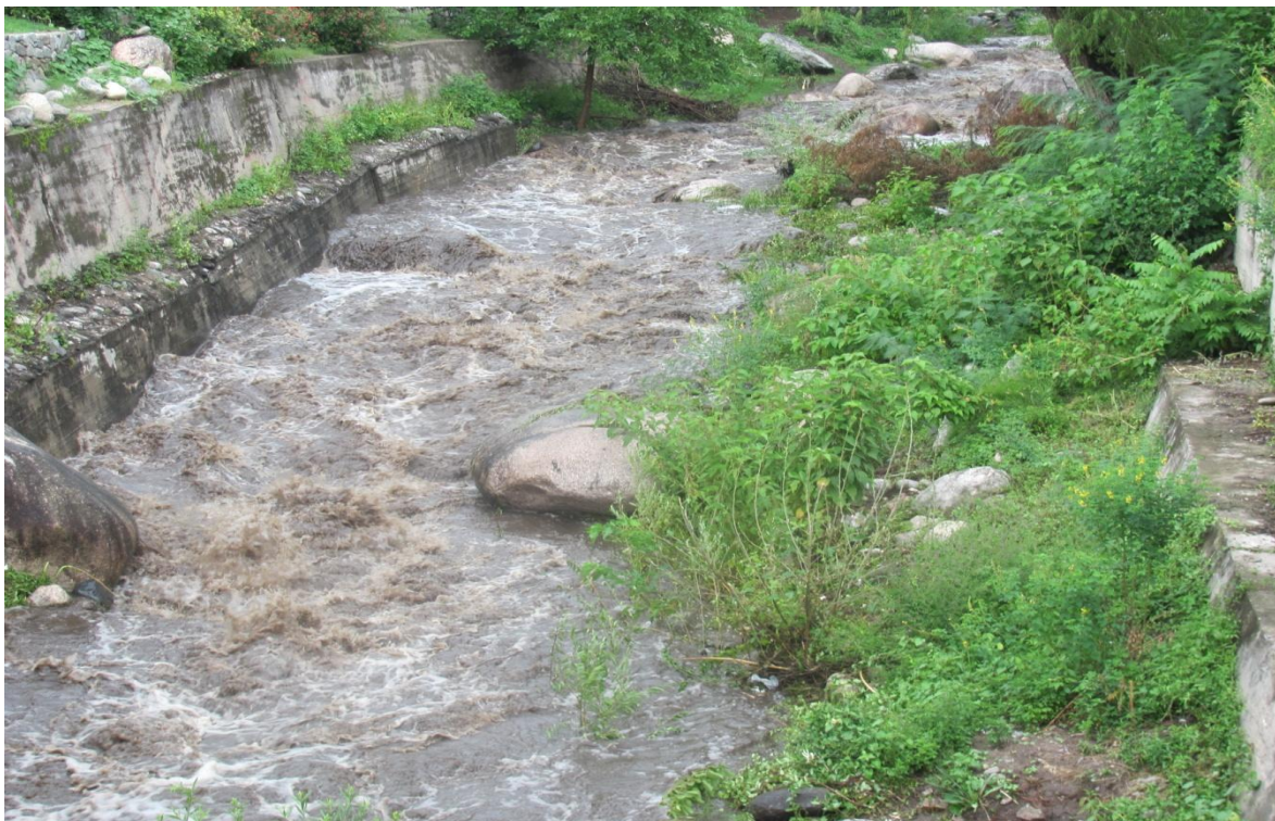
Figura 41. Vista aguas arriba cauce río Los Nogales en puente próximo a Iglesia de la Candelaria (Estructura 3)
