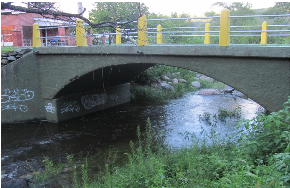
Figura 26. Estructura 1: Puente próximo a hostería Chicha (vista hacia aguas arriba)
