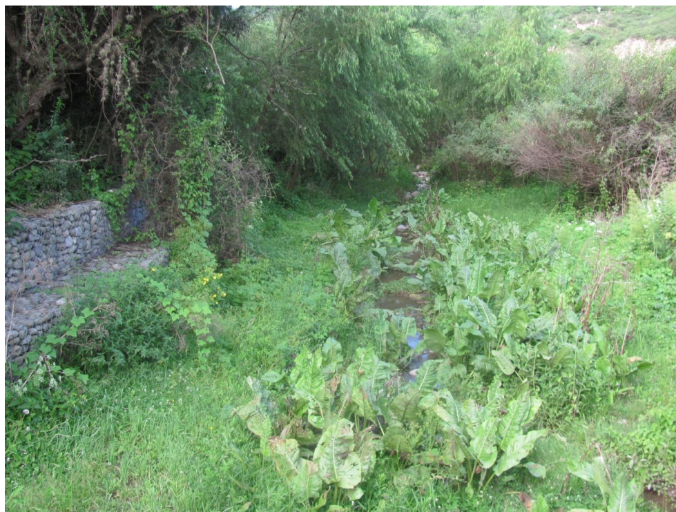
Figura 38. Protección de márgenes aguas abajo de alcantarilla faldeo al Cristo (Estructura 2).
