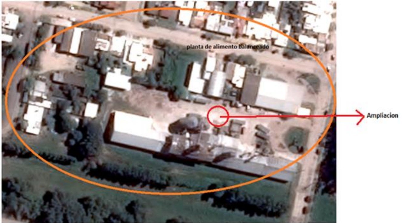
Figura 10: Imagen Satelital planta alimento balanceado Monte Maíz con indicación de la ampliación. Fuente: Google Maps.
