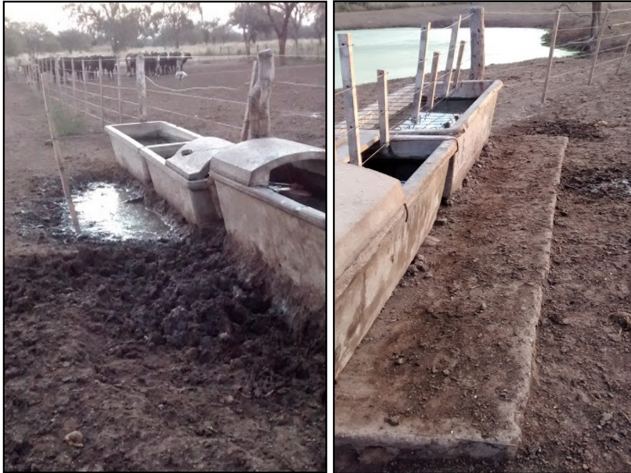
Figura 30: Formación de barro circundante por mal mantenimiento y dimensión incorrecta del piso de cemento.
