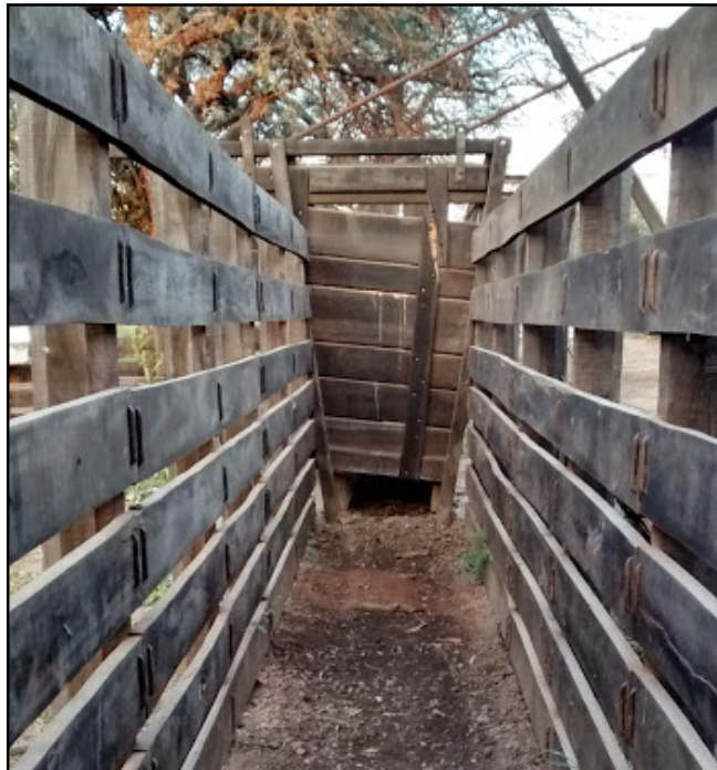
Figura 25: La manga no cuenta con piso antideslizante y posee paredes laterales con aberturas.
