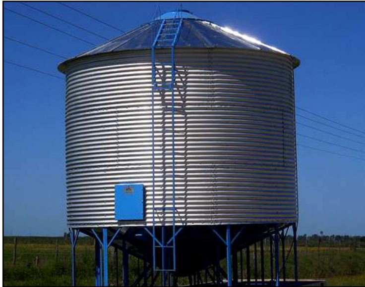
Figura 32: Silo de chapa para almacenamiento de grano de maíz destinado al engorde a corral.
