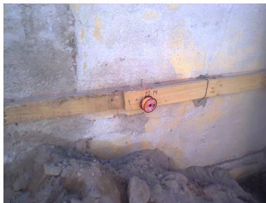
Fig. 23: tareas de replanteo. Se observa el corralito de madera
