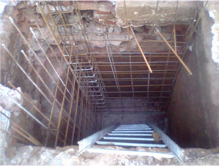
Fig. 18: pilote hormigonado
