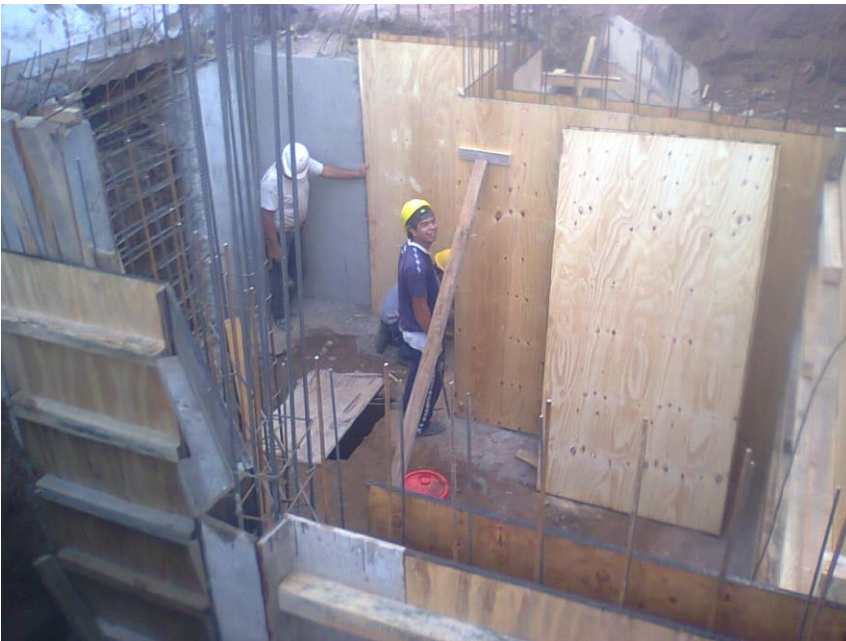
Fig. 21: subsuelo técnico con tabiques encofrados
