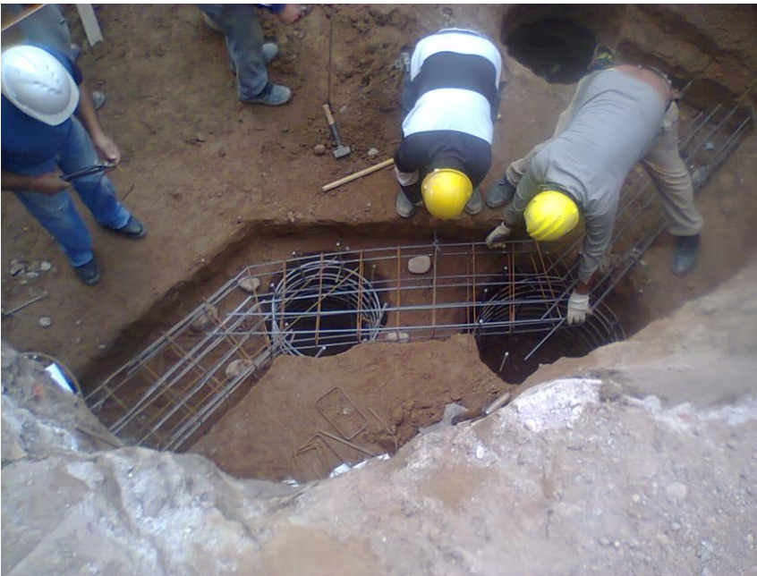
Fig. 32: pilotes y zapata de tabiques de subsuelo
