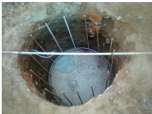
Fig. 28: pilote luego de ser hormigonado
