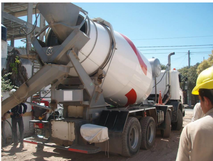
Fig. 29: hormigonado de pilotes
