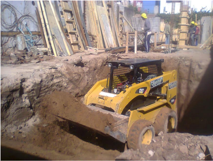
Fig. 31: excavación de subsuelo con mini cargadora
