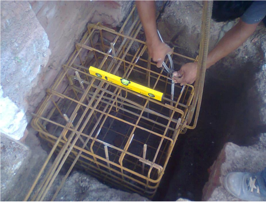
Fig. 16: nivelación de cabezal
