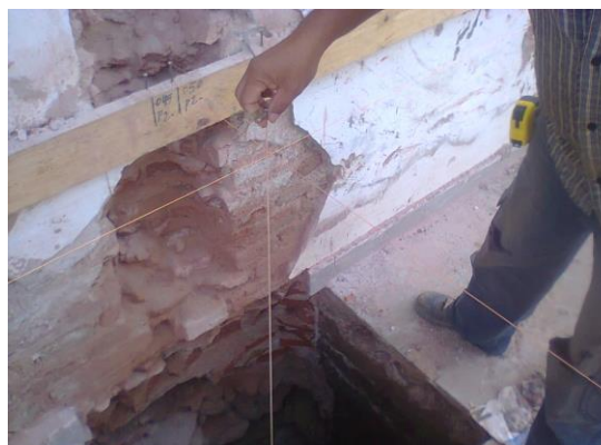
Fig. 25: Armero oficial verificando el eje del pozo con su plomada.
