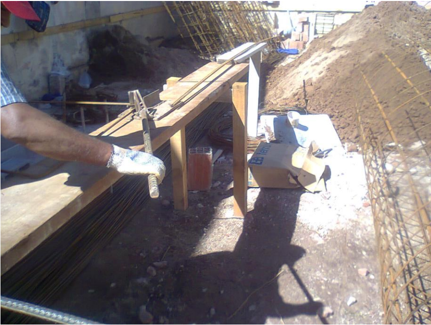
Fig. 14: trabajo con armaduras
