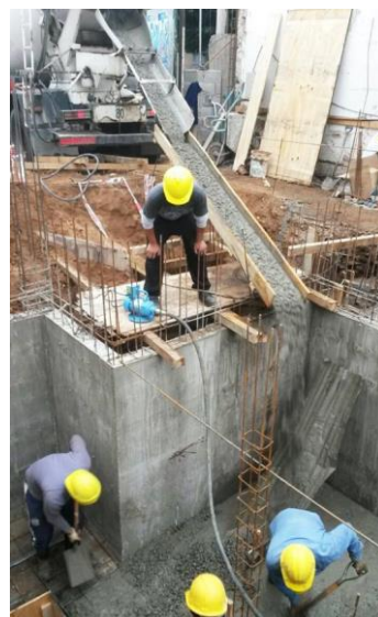
Fig. 30: hormigonado de subsuelo
