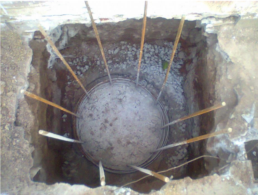
Fig. 17: pilote hormigonado
