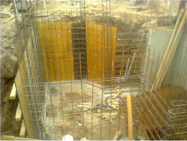
Fig. 33: encofrados de tabiques de subsuelo
