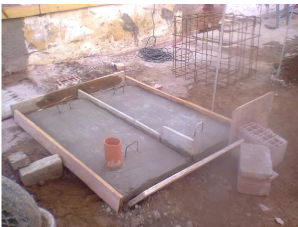
Fig. 22: losa de baño esperando a endurecer y ser colocada.
