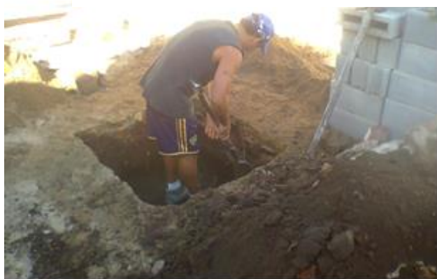
Fig. 26: excavación de cabezal y posteriormente el pozo
