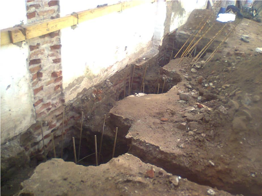
Fig. 15: pilotes y vigas riostra excavadas
