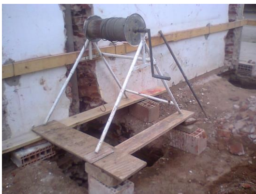
Fig. 24: pozo siendo excavado
