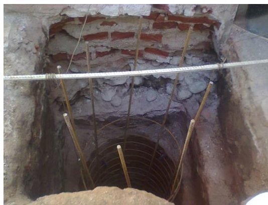
Fig. 27: pilote esperando a ser hormigonado
