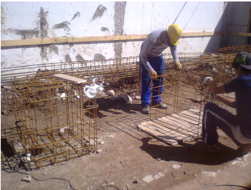
Fig. 13: replanteo y elaboración de armaduras
