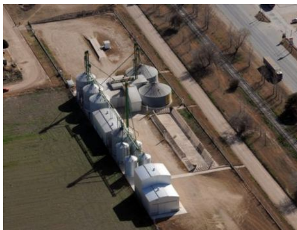
Figura 15: Planta industrial La Troja SRL.
