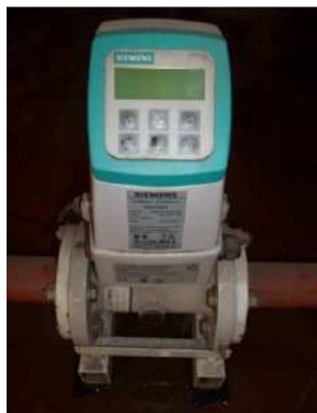
Fig.2.7 – Caudalímetro Siemens modelo MAG 5100W
