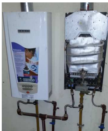
Fig.2.1 – Calefones conectados en paralelo
