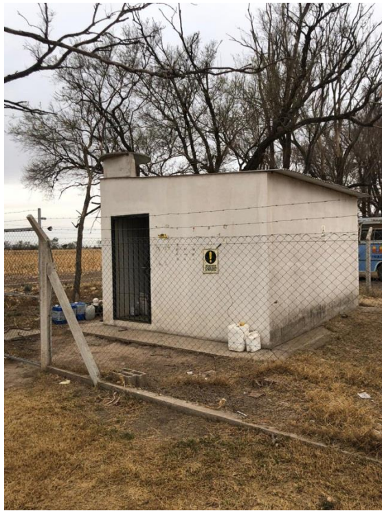
Figura 23: Depósito de fitosanitarios cercado, con señalización y separado de áreas concurridas y cultivos.
