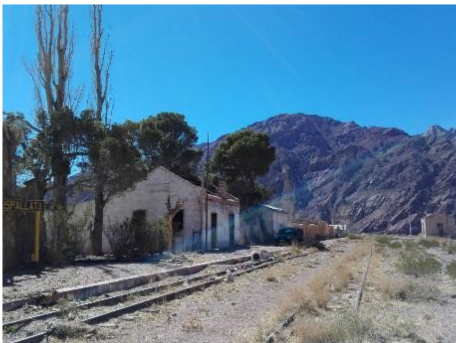
Vista de conjunto hacia el NE
