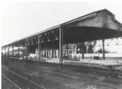
Figura 3: Gare Metálica da Estação Guanabara em 1915.
