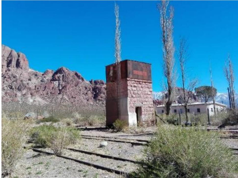
Vista tanque de agua
