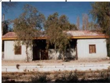
Estación Capdeville en Las Heras. Fachada principal. Foto: Alejandro Grinberg (2002).
