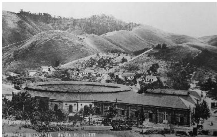
Figura 2 – Rotunda de Barra do Piraí (RJ).
