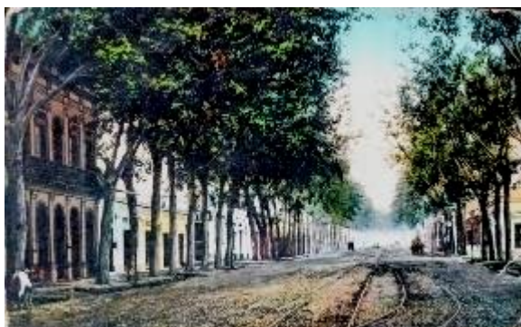
Tendido del las vías del tranvía en la avenida San Martín (Colección: Guillermo Romero).
