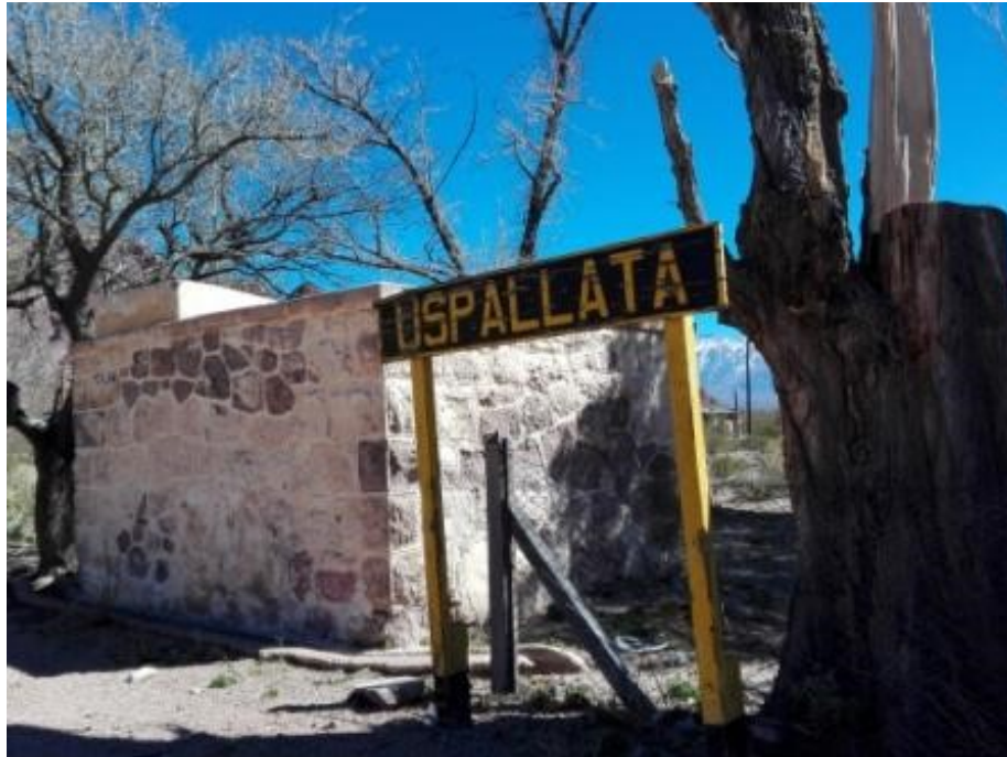
Exterior bloque sanitarios
