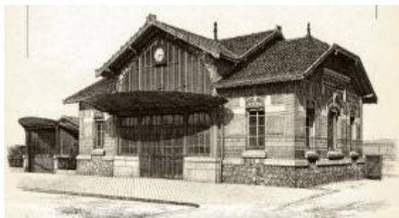
Figure 23. Troisième gare de Clamart édifée en 1903
