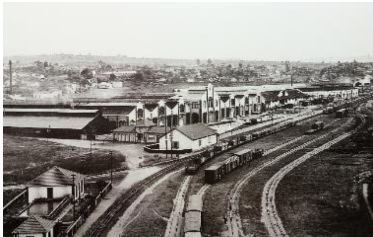
Figura 3 – Complexo Ferroviário de Bauru (SP).
