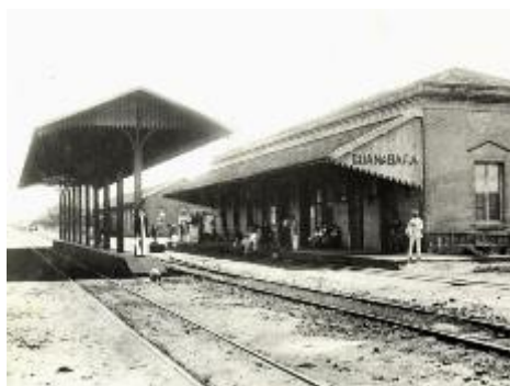
Figura 11: Plataforma de embarque da estação Guanabara e armazém ao fundo, entre 1894 e 1914.
