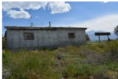
Estación Capdeville en Las Heras. Fachada principal. Foto: Alejandro Grinberg (2002).
