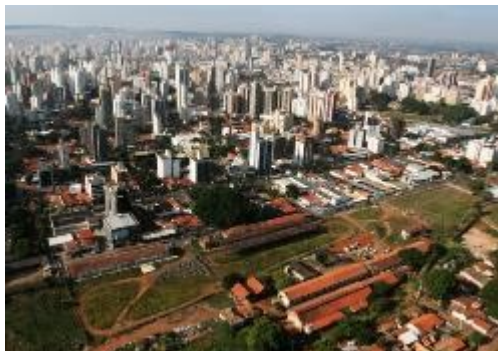
Figura 10: Vista área do complexo ferroviário, s/d. Campinas.
