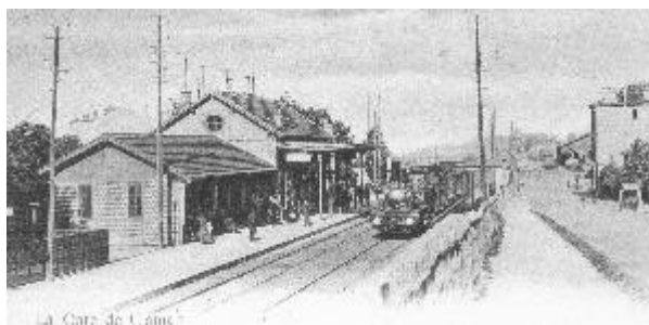
Figure 22. Deuxième gare de Clamart reconstruite en 1870
