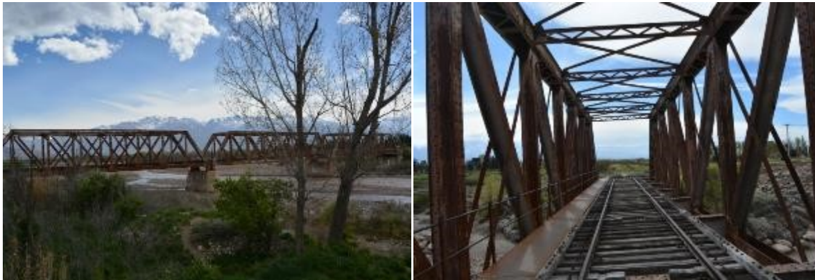
Vista general del puente ferroviario sobre el río Tunuyán (izquierda) que vincula la localidad de Campo los Andes en Tunuyán, con la de La Consulta, en San Carlos. A la derecha perspectiva interior del puente, con su trocha de 1.66 metros. Fotos: Juan José De Haro (2017)
