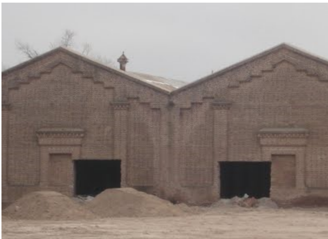
Abertura de vanos sobre una de las fachadas del Mercado “Victoria”.
