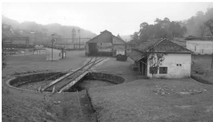
Figura 6 – Vila Ferroviária de Paranapiacaba (SP).
