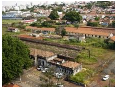
Figura 11: Bens ferroviários pertencentes ao complexo em alto nível de degradação s/d.
