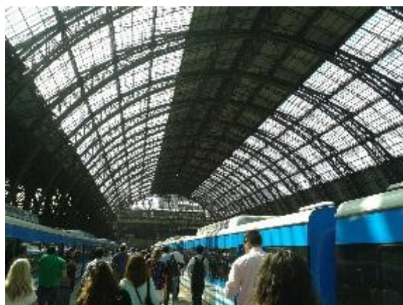
Vista cubierta andenes
