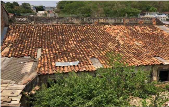
Figura 18: Vista interna da edificação. Fonte: Próprio Autor, 2017.
