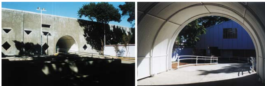
Figura 4: Oficina Boraceia. Face e túnel de acesso. Fonte: Loebcapote.
