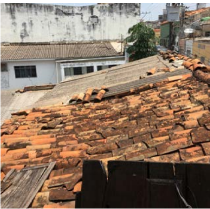
Figura 19: Cobertura do Nível I. Fonte: Próprio Autor, 2017.
