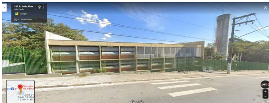
Figura 2. Fachada principal da Escola Municipal de Ensino Fundamental Estação Jaraguá onde se desenvolve o projeto. Fonte: Google Street View. Disponível em:
