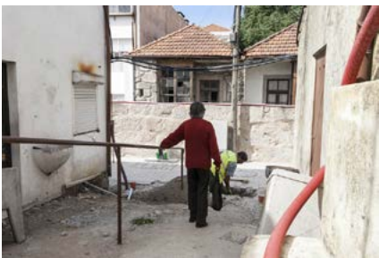
Fotografias 5 e 6 – Estaleiro/Obra - 1.ª Fase - colocação dos moradores nas habitações para o início de obra. Fonte: Arquivo do LAHB
