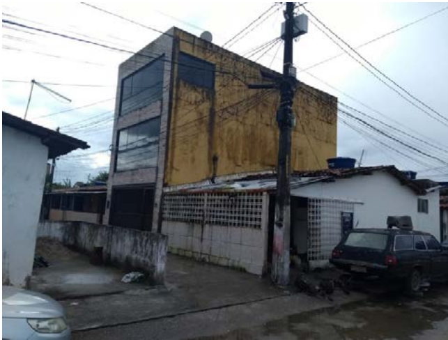
Imagem 4: Casas após passarem por diversos processos de modificação. Fonte: ROCHA et al , 2019.
