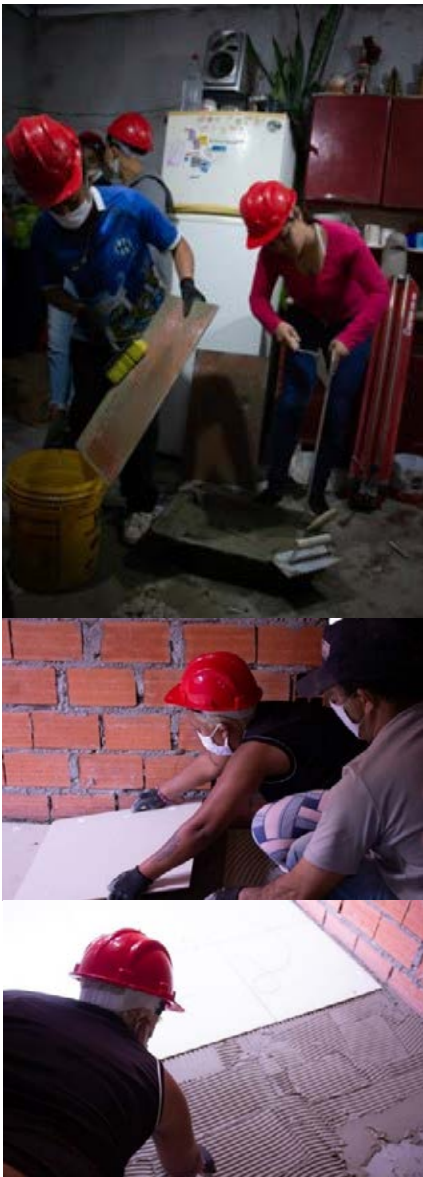
Figura 23: Atividades práticas do curso de Azulejista: preparação de peças e sequência de assentamento de piso cerâmico.
