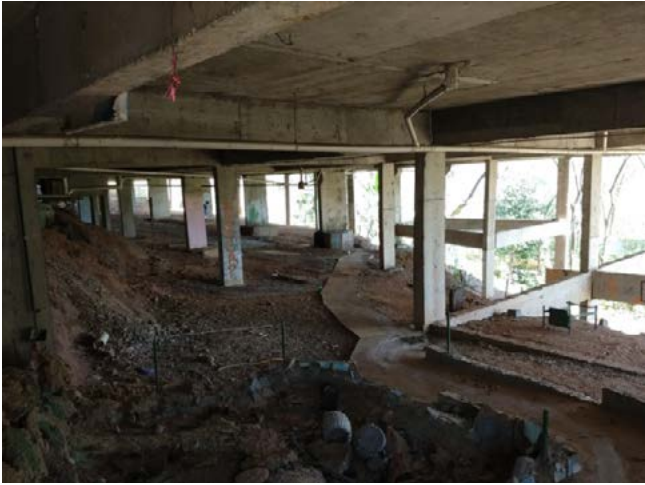
Figura 4. Área coberta do Espaço Semear. Acesso principal e estruturas que fazem parte da fundação da escola. Fonte: Acervo do Escritório Modelo ÁTICO.
