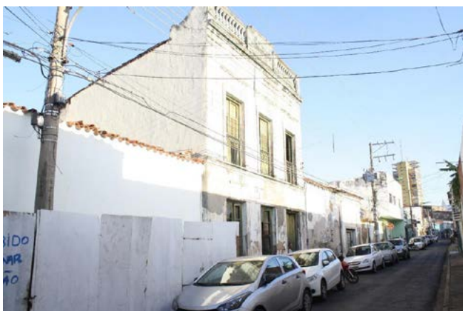
Figura 04: Fachada da Rua Engenheiro Ricardo Franco. Fonte: Próprio Autor, 2017.
