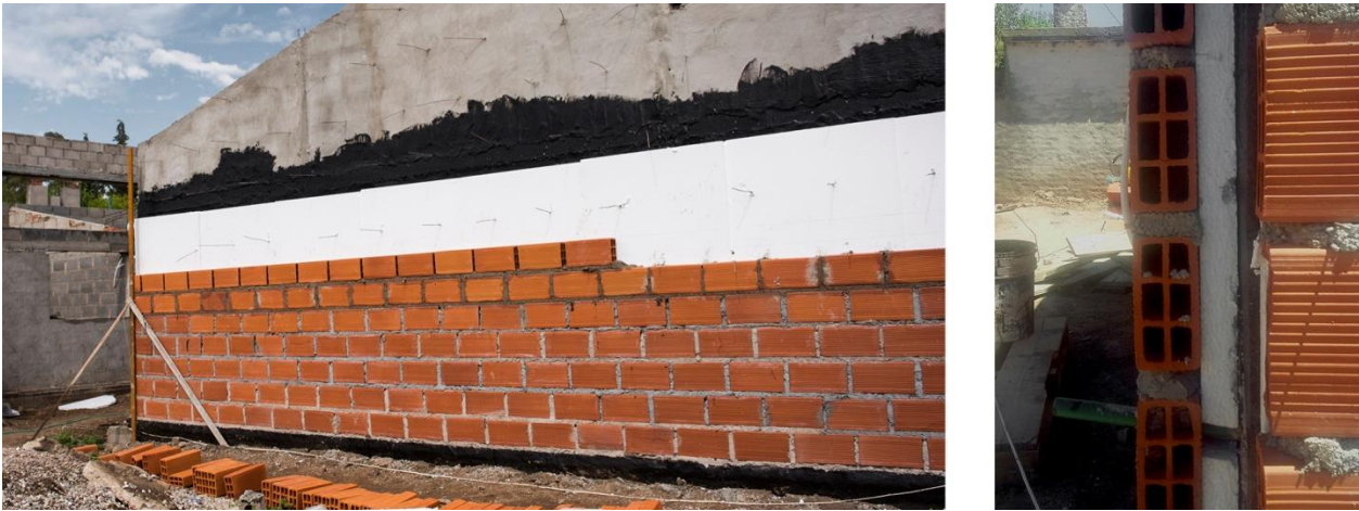
Figura 3: Fotografías de las viviendas en construcción. Composición de la envolvente vertical.
