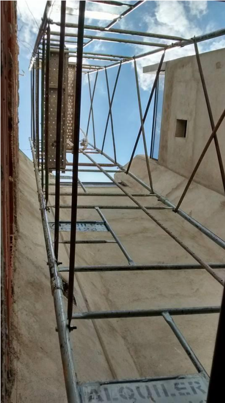
Fig. 15: andamios necesarios para tarea de revoque externo en patio este.
