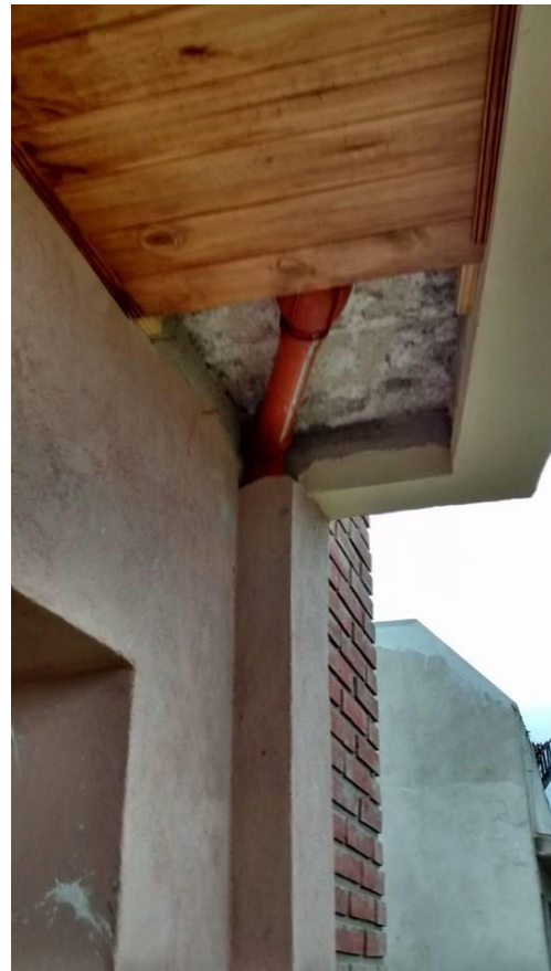
Fig. 25: detalles de caños de desague pluvial, que implican además detalles de revestimientos exteriores (cielorraso de balcones).
