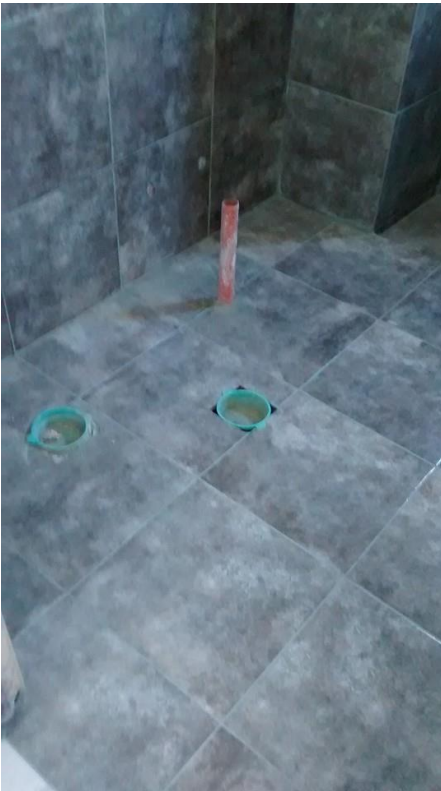
Fig. 28: detalles de terminación en cerámicos
