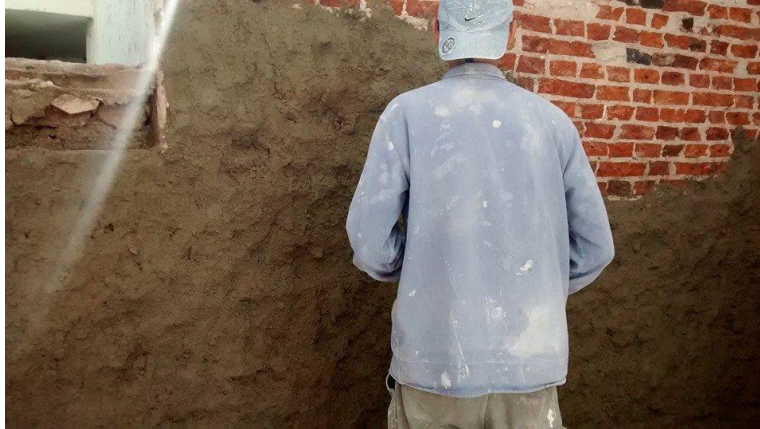
Fig. 23: terminación de detalles de revoque.
