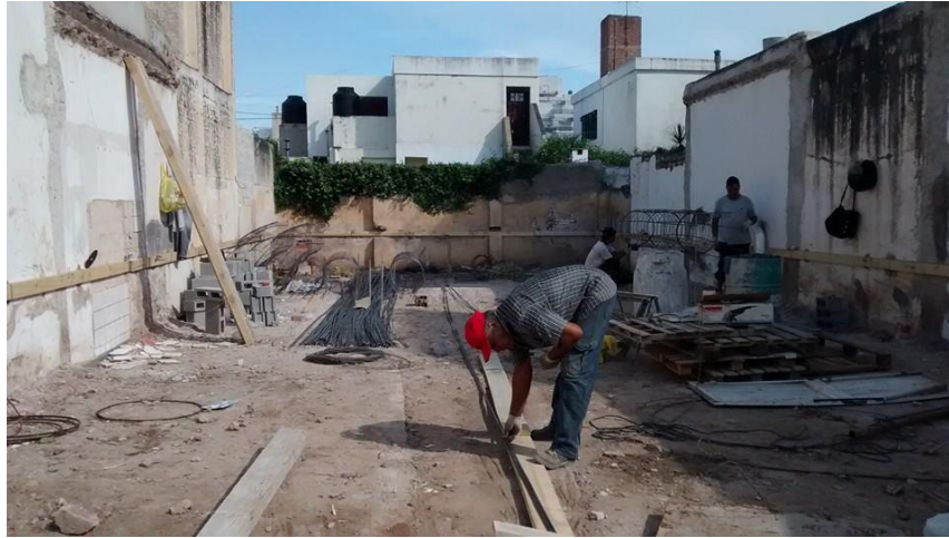
Fig. 11: tareas de replanteo. Se puede observar al fondo el acopio de acero para el posterior armado de pilotes.
