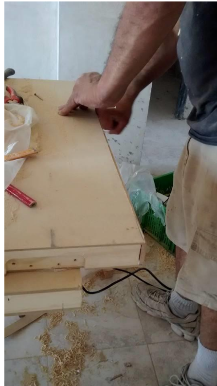
Fig. 29: detalles de terminación en carpintería.
