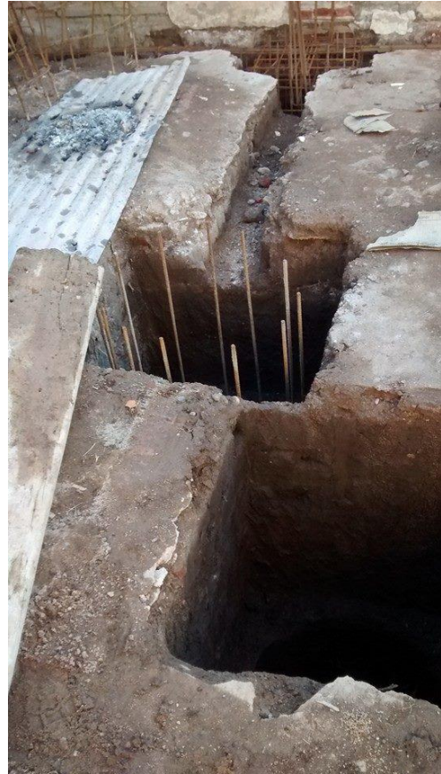
Fig. 13: excavación de vigas riostras y pilotes, y armado de fundaciones.
