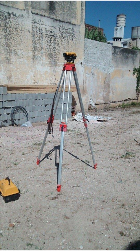
Fig. 9: nivel empleado en la nivelación topográfica en esta obra.
