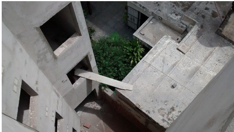
Fig. 19: limpieza de techo de propiedad vecina colindante.
