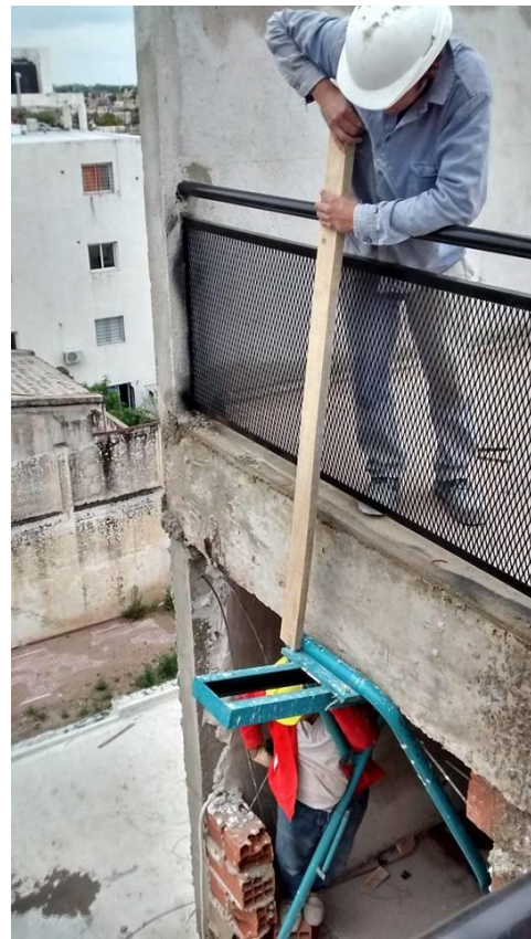
Fig. 21: tareas de desarmado de guinche, que impedía terminar con la mampostería y revestimientos del sector este del edificio.
