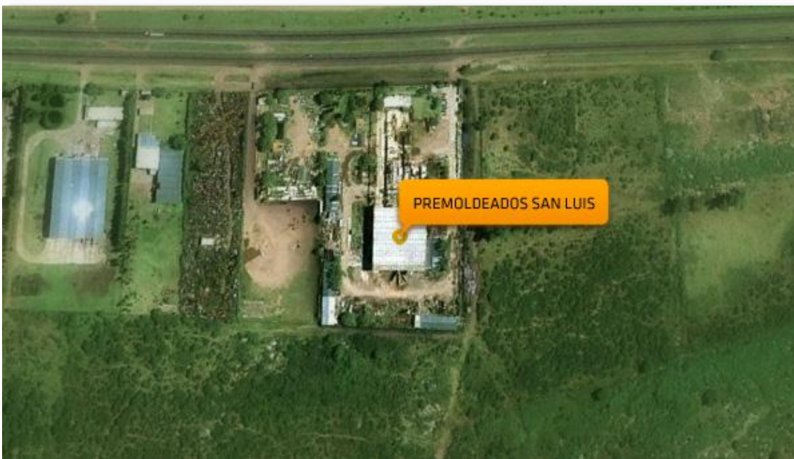
Figura 8.1. Ubicación Planta de Empresa Pretensados San Luis S.R.L.
