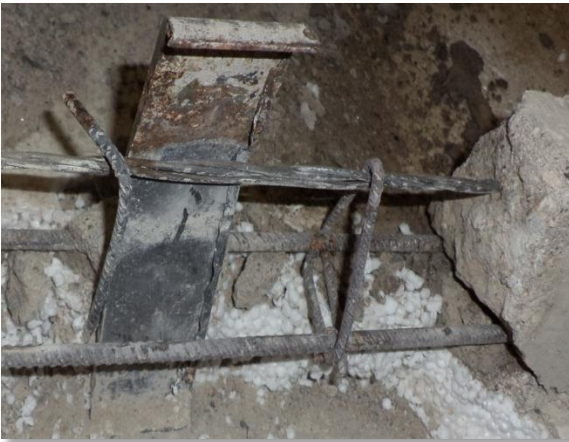
Figura 10.6. Detalle Armadura Nervio Transversal Panel PL0765.
