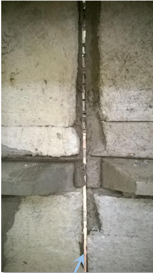
Separación entre Paneles: 1 cm
