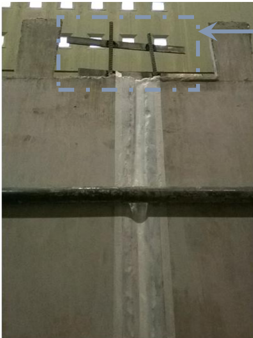
Figura 12.17. Detalle de unión de Hierros en PL0765.
