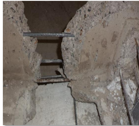
Figura 10.7. Detalle Nervio Longitudinal Panel PL0765.
