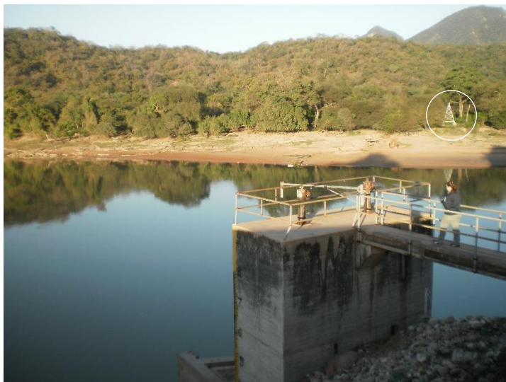
Figura 33.- Sensor Kalesto y Torre de sección de aforo julio 2014 (Cristanchi y Testa Tacchino 2014).
