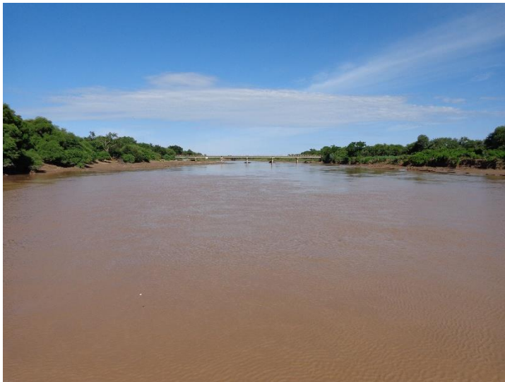
Figura 49.- Vista hacia aguas arriba de la sección de aforo de Misión La Paz, se observa el puente internacional, enero 2014 (Cristanchi y Testa Tacchino 2014).
