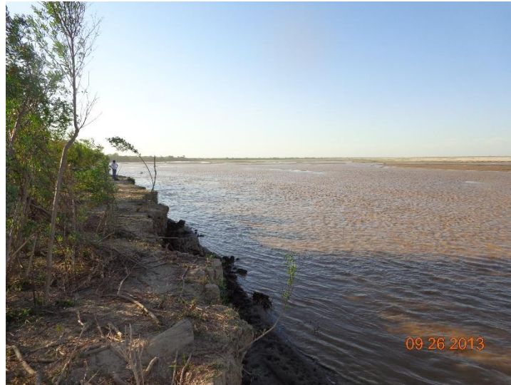
Figura 203.- La Garrapata, vista hacia aguas arriba, septiembre 2013 (Baldissonne, Cristanchi y Testa 2013).
