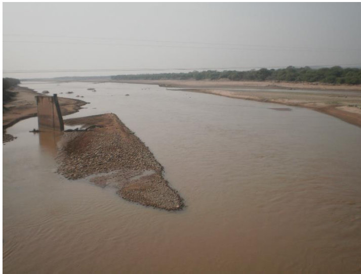
Figura 231.- Aguas Abajo del Puente Carretero, septiembre 2013 (Baldissone, Cristanchi y Testa Tacchino 2013)
