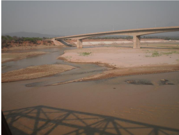
Figura 230.- Aguas Arriba del Puente Carretero, septiembre 2013 (Baldissone, Cristanchi y Testa Tacchino 2013)
