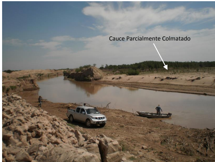
Figura 188.- Canal Las Torres y taponamiento del cauce seco argentino, septiembre 2013 (Baldissone, Cristanchi y Testa 2013)
