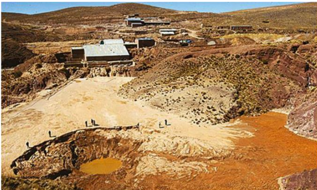
Figura 281.- Rotura dique de Colas, Mina Santiago Apóstol (Menéndez 2014).
