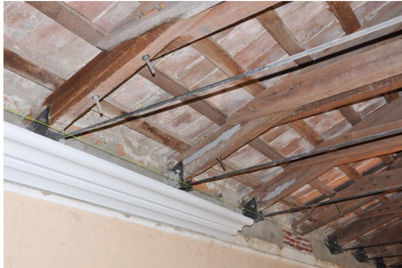
Figura 13 Reparación de fisuras paralelas
