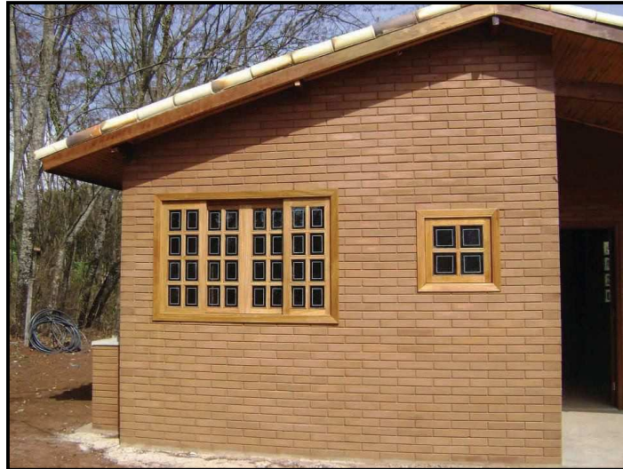
Figura 2.5: Vivienda construida con mampuestos de suelo-cemento vistos
