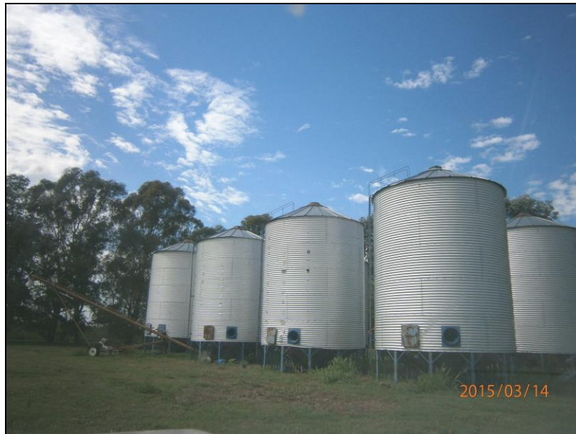
Figura 31: Silos de chapa en buen estado de conservación.
