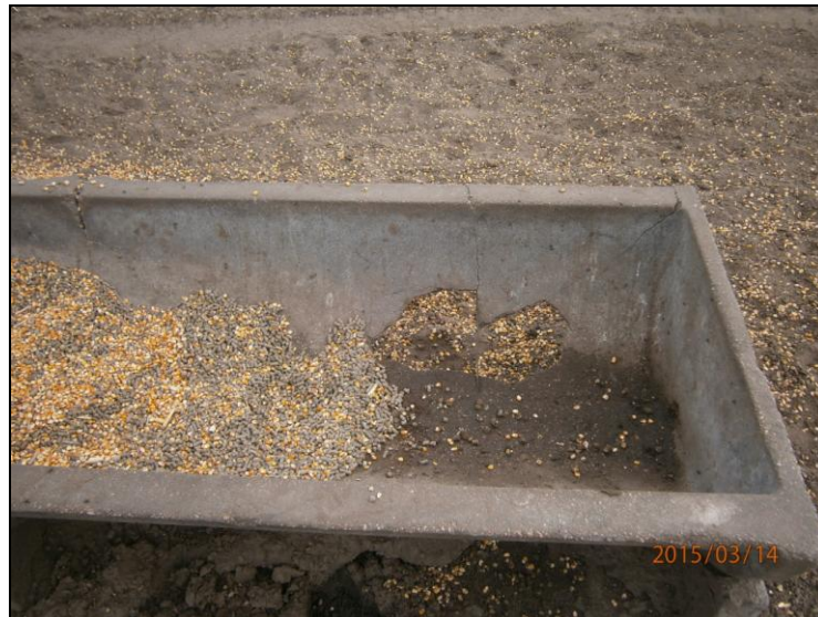
Figura 25: Comedero en mal estado de conservación.
