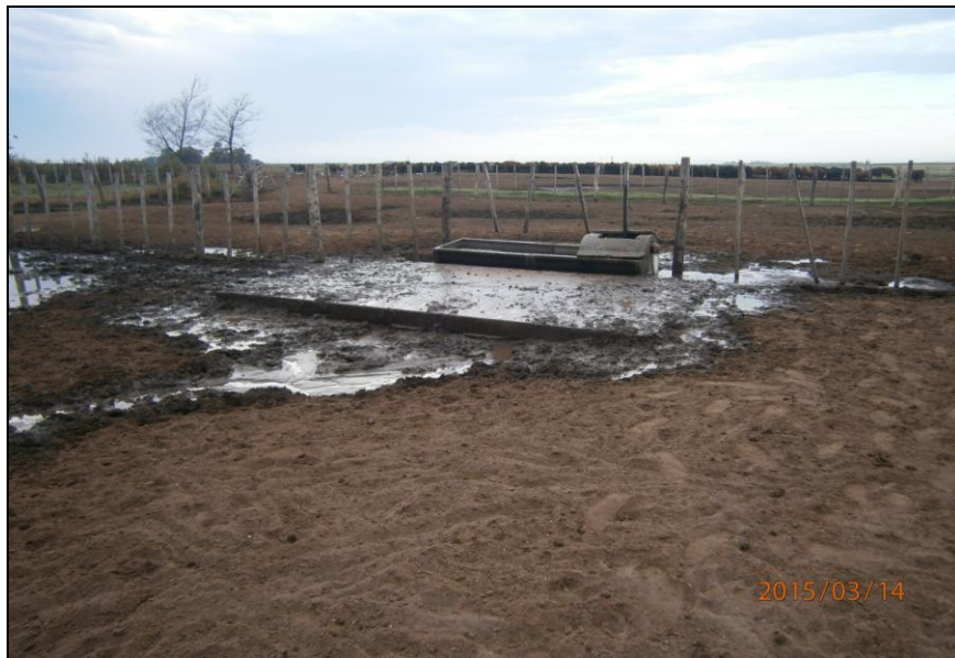
Figura 27: Pérdida ocasional de agua por ruptura de bebedero.
