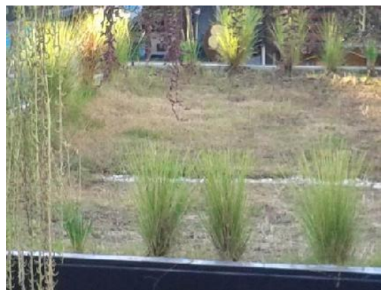
Figura 3. Vista de la cubierta verde-invierno
