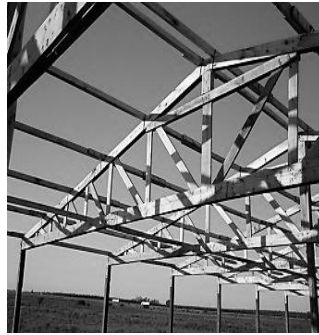
Imagen 1: Ejemplos de estructuras reticuladas planas.
