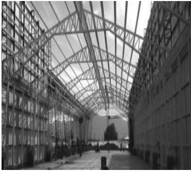
Imagen 1: Ejemplos de estructuras reticuladas planas.
