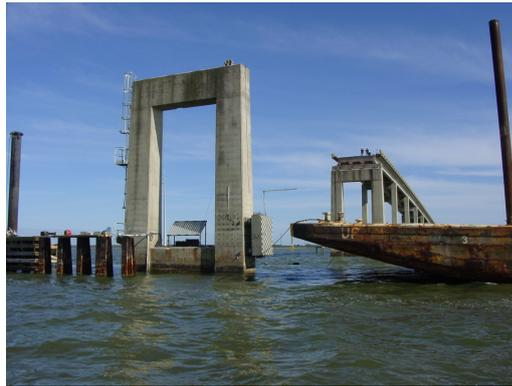
Figura 2.4: Ensayo de impacto de barcas a escala real realizado por la Universidad de Florida y el Departamento de Transporte de Florida (Consolazio et al., 2008)
