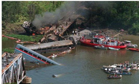
Figura 1.2: Tren descarrilado en Puente Big Bayou Canot luego de ser embestido por un grupo de barcasas (1993)
