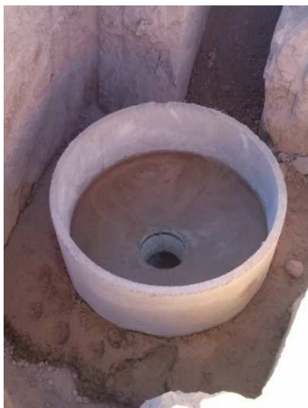
Figura Nº 2.7: Construcción de la cámara
