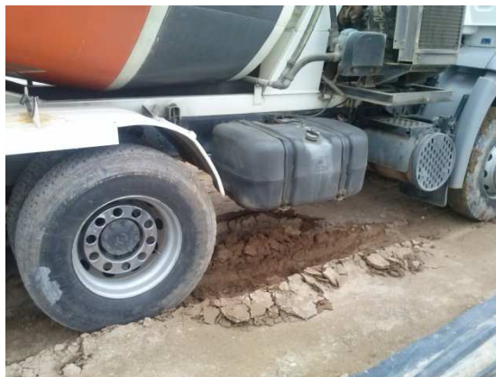
Figura N° 5.4: Plastificación del suelo
