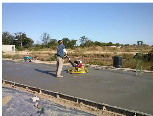
Figura N° 3.10: Fratazado de la losa
