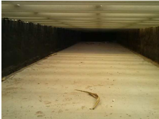
Figura Nº 2.6: Interior de la fosa
