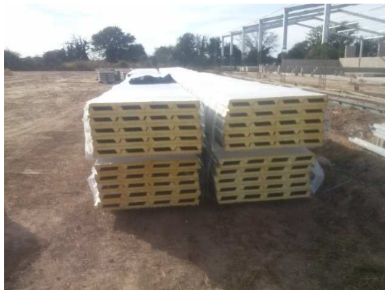
Figura N° 2.19: Acopio de chapas
