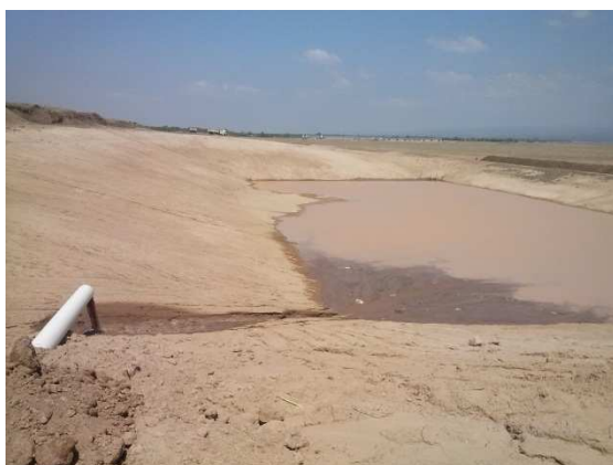
Figura N° 2.9: Lagunas Sitio III
