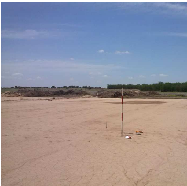
Figura N° 4.4: Replanteo de los vértices del galpón
