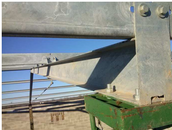
Figura N° 3.4: Unión columna-cabreada
