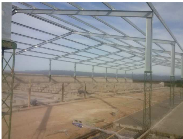
Figura N° 2.11: Esqueleto de la estructura metálica
