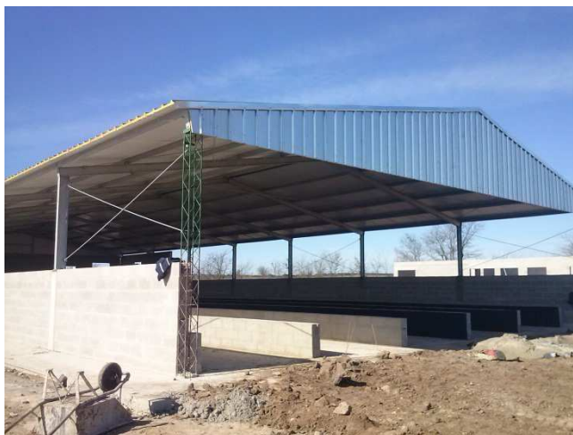
Figura N° 1.6: Construcción fachada oeste Recría
