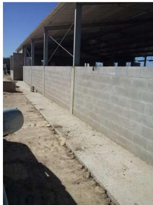
Figura N° 2.18: Abertura para las cortinas
