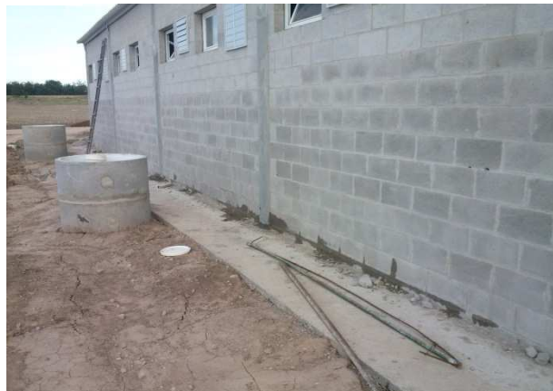
Figura Nº 2.8: Cámaras ubicadas al costado del galpón
