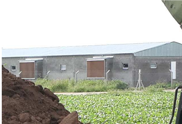
Figura N° 2.17: Paneles evaporadores
