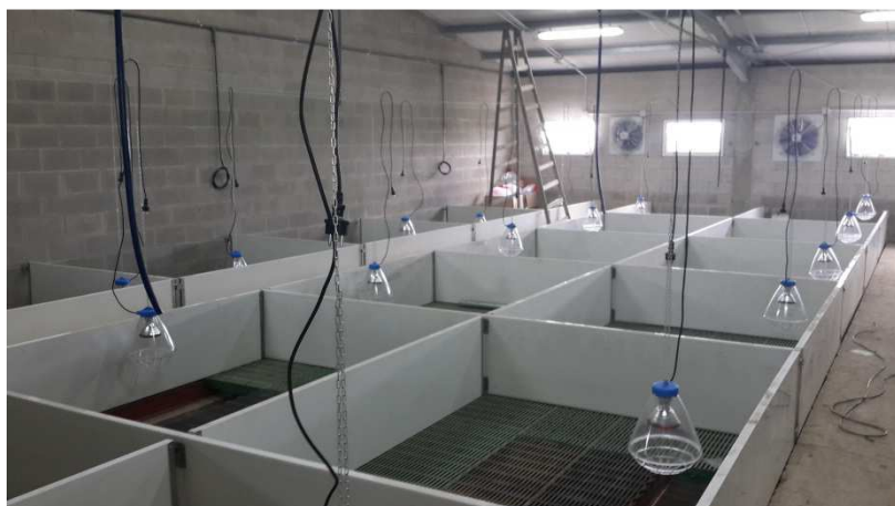
Figura N° 1.9: Interior Sala de Maternidad
