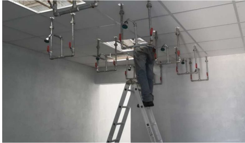
Figura Nº 1.4: Construcción de la zona de duchas
