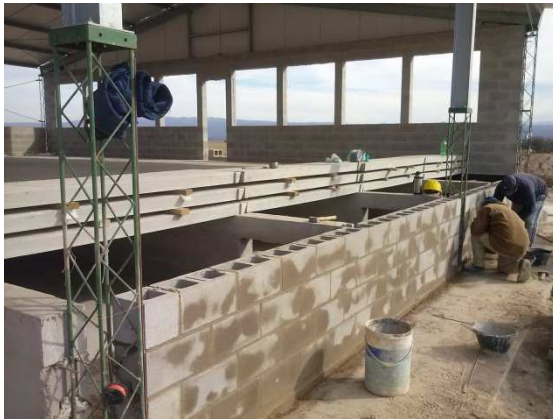
Figura N° 3.12: Construcción segundo muro lateral luego de colocar los slats
