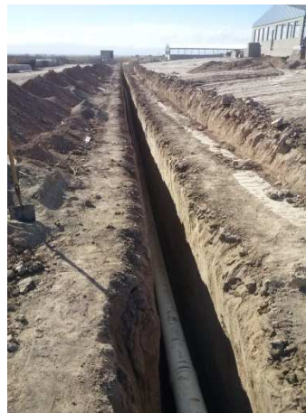
Figura Nº 4.10: Zanja con caños de desagües
