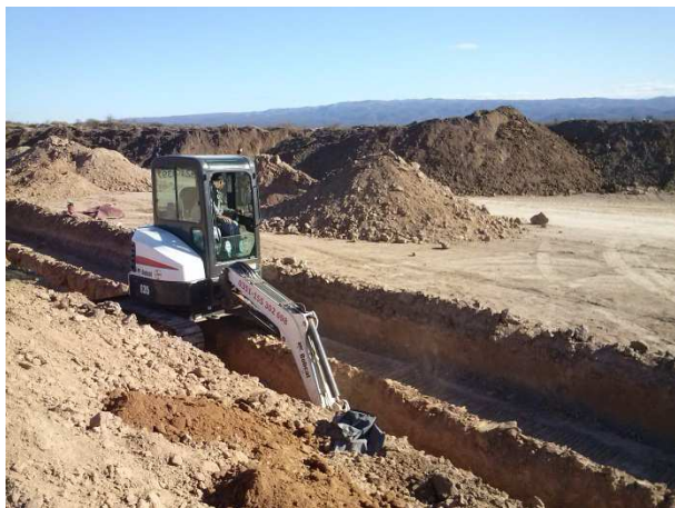
Figura Nº 4.9: Pequeña retro cavando
