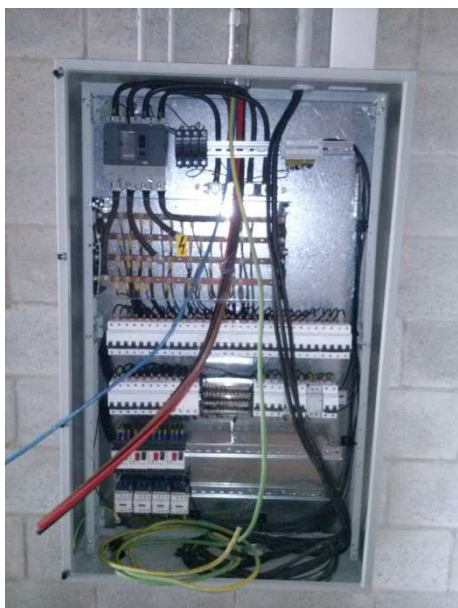
Figura N° 3.17: Tablero tipo galpón Terminación
