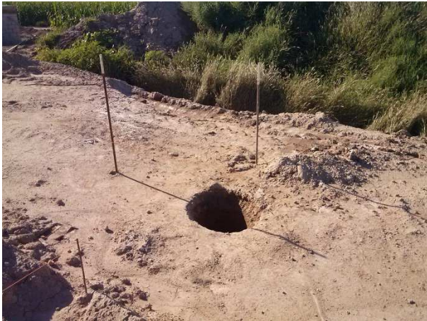
Figura N° 3.2: Control de escuadras
