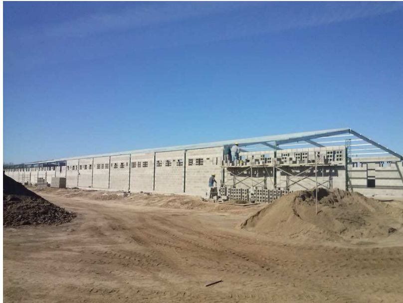
Figura N° 3.11: Elevación de mampostería
