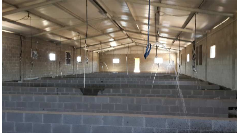
Figura N° 1.10: Prueba de agua en el galpón
