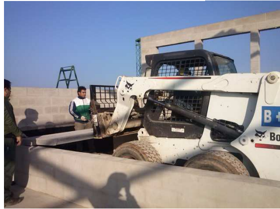
Figura N° 3.12: Construcción segundo muro lateral luego de colocar los slats
