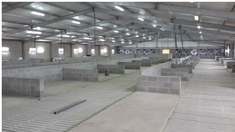
Figura N° 1.8: Interior Galpón Gestación Grupal
