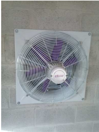
Figura N° 2.12: Extractor con carcasa y aletas plásticas
