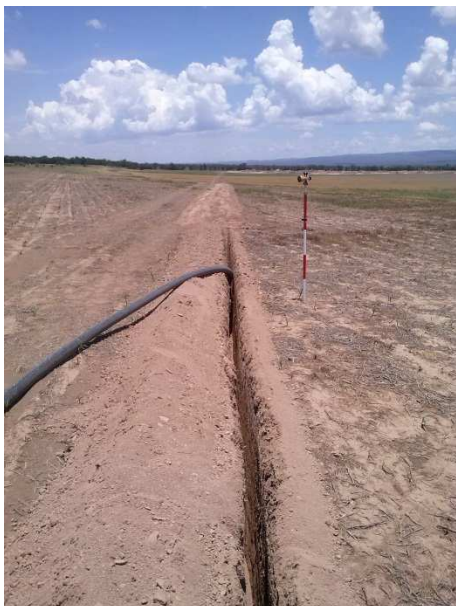
Figura N° 4.6: Zanja uniendo ambas cisternas
