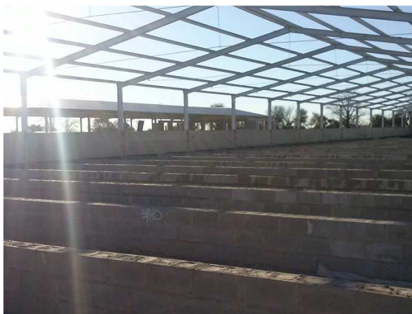
Figura N° 2.1: Fajas de mampostería para los slats
