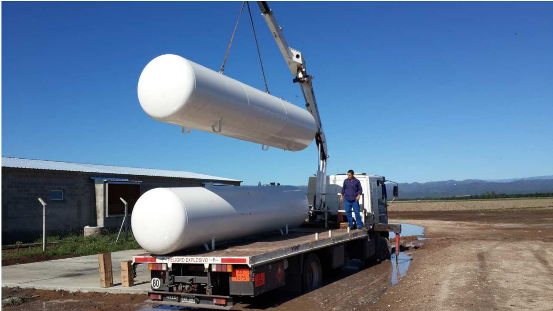
Figura N° 2.16: Descarga de los zeppelín sobre la plataforma
