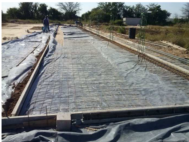
Figura N° 3.7: Colocación de polietileno y armaduras
