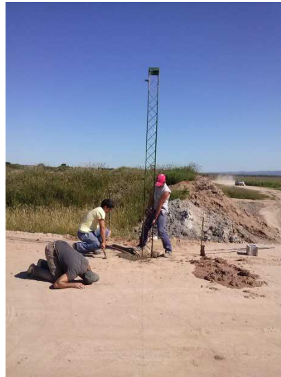
Figura N° 3.3: Colocación de la columna y control de su plomo
