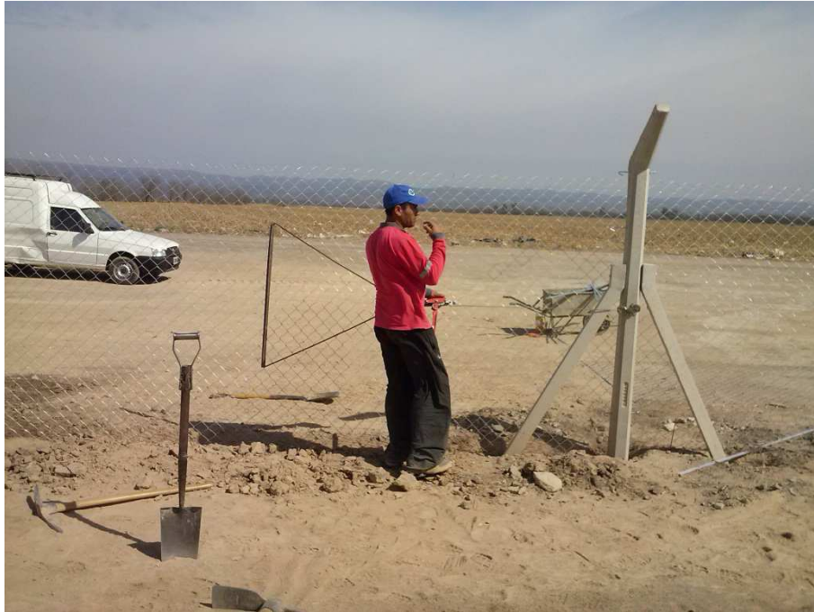
Figura N° 3.19: Tensado malla romboidal
