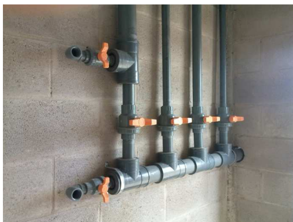
Figura Nº 3.15: Colector galpón Maternidad
