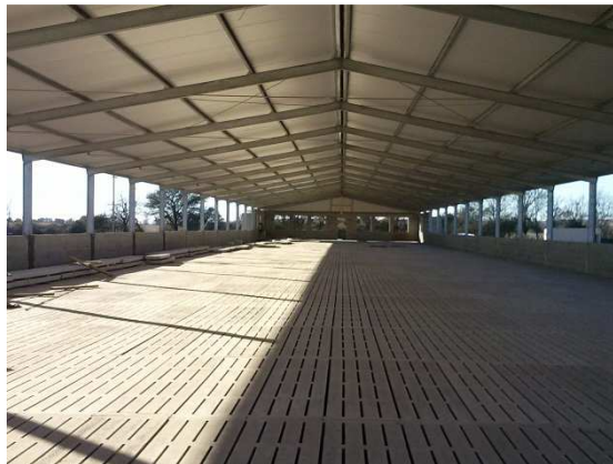
Figura N° 1.11: Piso de slats en Terminación
