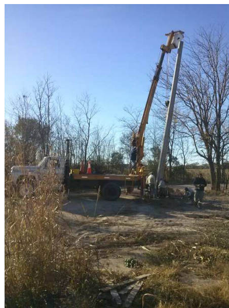
Figura N° 3.18: Colocación línea de media tensión
