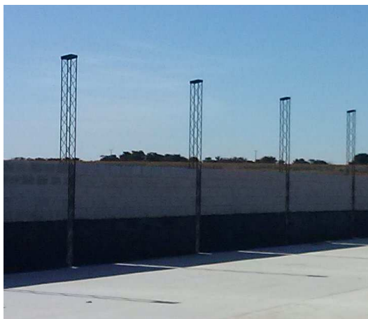
Figura Nº 3.14: Impermeabilización del perímetro
