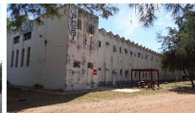
3 Sede Parque Industrial
