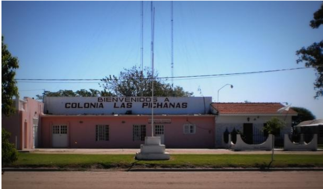
Figura 2.5: Calle principal de Colonia Las Pichanas. A la derecha, la casa comunal
