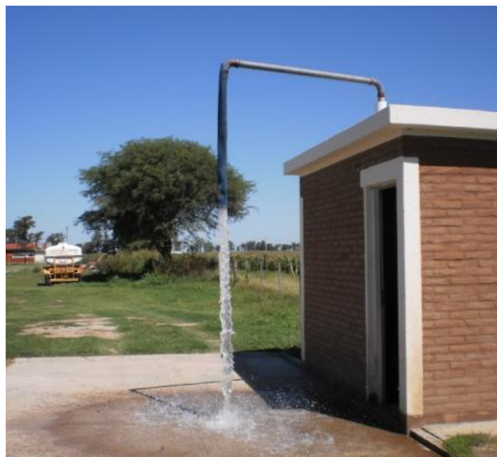
Figura 5.33: Casilla de inspección donde se instalará el inyector Venturi
