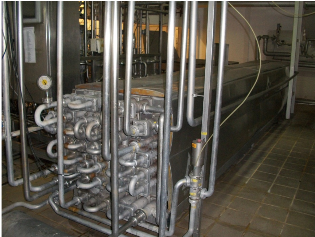
Figura D-3: Intercambiador de calor tubular.
