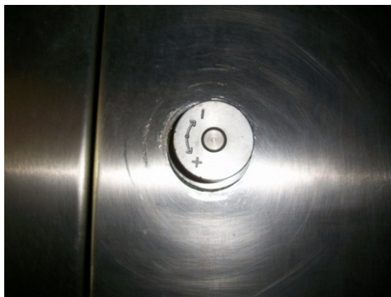
Figura 4-12: Comando de accionamiento del sistema de seteo envasadoras TBA.
