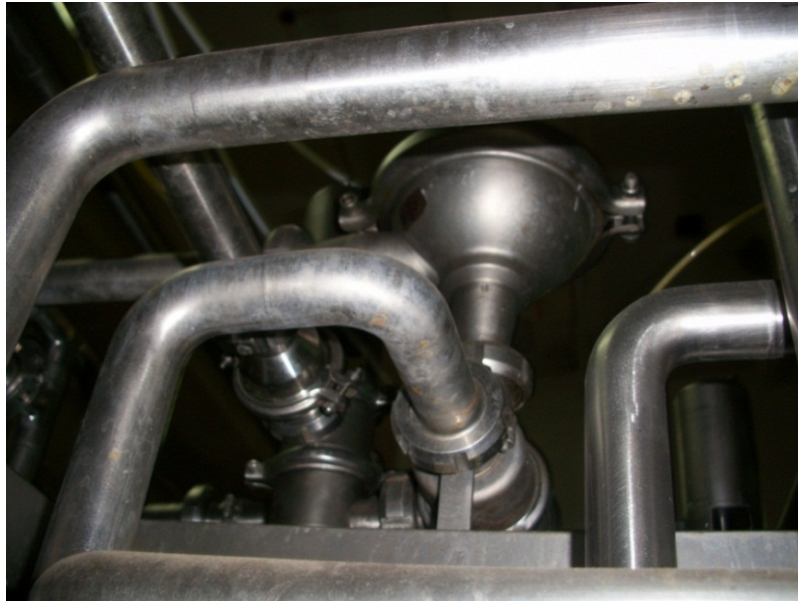
Figura 4-28: Válvula de contrapresión envasadoras.
