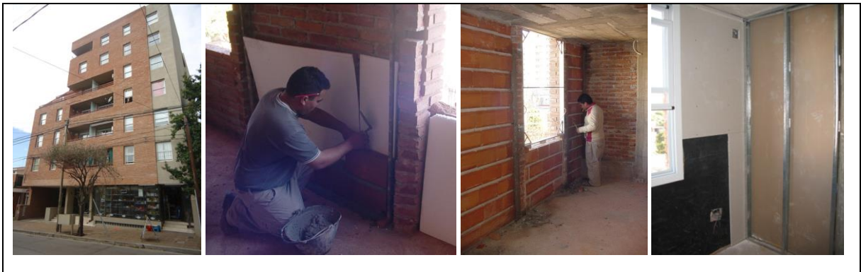
Fig. 9: Vistas del edificio. Construcción de la envolvente lateral Oeste.
