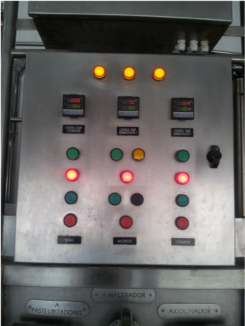
Figura 16: Tablero electrónico para control de parámetros de producción.
