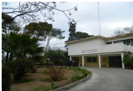
Figura 2. Vista exterior del edificio en 2013.
