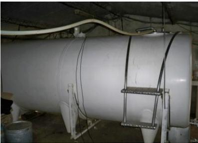
Está ubicada detrás de la sala de ordeño y a la par de la sala de máquinas. Cuenta con una superficie de 10 m<sup>2</sup> aproximadamente. El tanque de leche (Fig. 12) tiene una capacidad de 6000 litros con doble placa de refrigeración.
