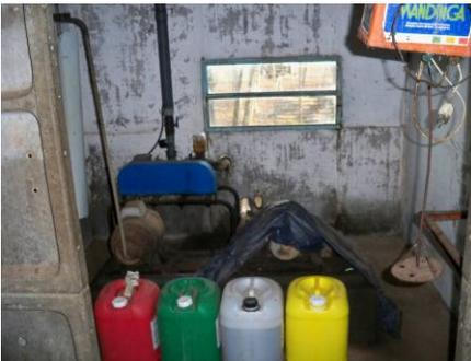
Se ubica detrás de la sala de ordeño (Fig. 13), con una superficie de 4 m<sup>2</sup> y en donde se encuentra la bomba de vacío y el motor. También se utiliza como depósito de detergentes, desinfectantes y otros productos.
