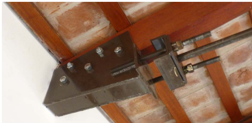
Figura 8: Detalle Anclaje tensor
