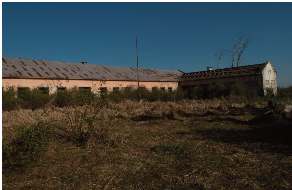
Imagen 3. Vista de la escuela desde el patio trasero. Fuente: Fotografía de Federico Fortini, 2013.
