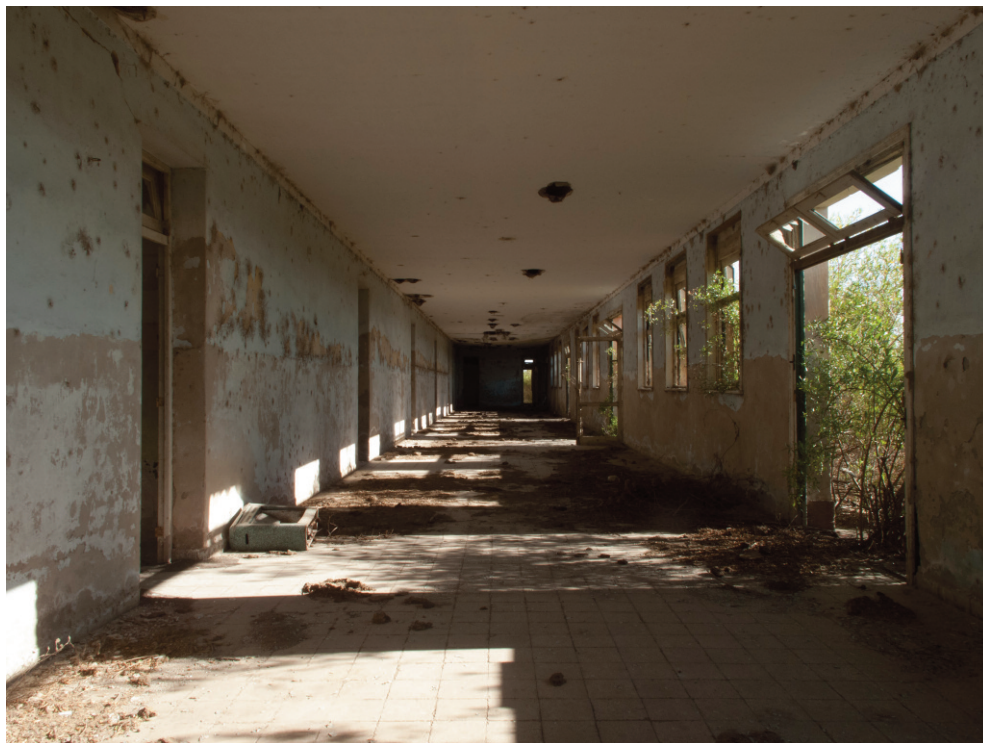
Imagen 2. Pasillo central de acceso a las aulas. Fuente: Fotografía de Federico Fortini, 2013.
