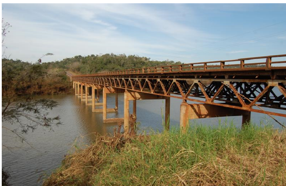
Figura 2.3: Fotografía del puente en su estado actual, vista lateral.
