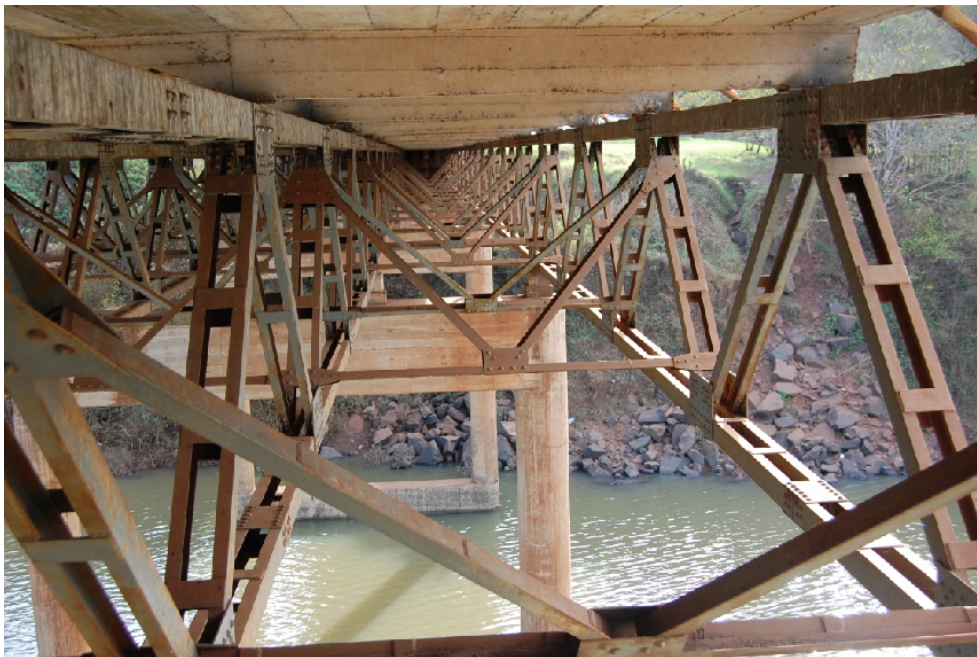
Figura 2.5: Fotografía tomada desde abajo del tablero. Se observan vigas longitudinales, planos de rigidización, nervios transversales y losa de hormigón armado y pilas de apoyo.
