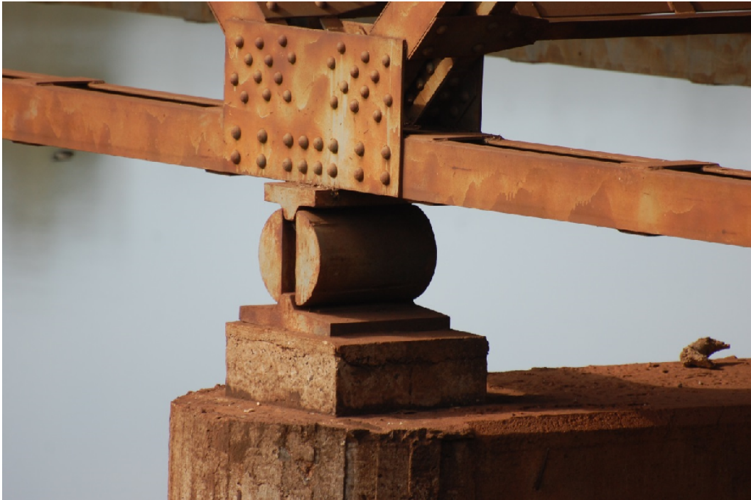
Figura 2.9: Apoyo tipo móvil.
