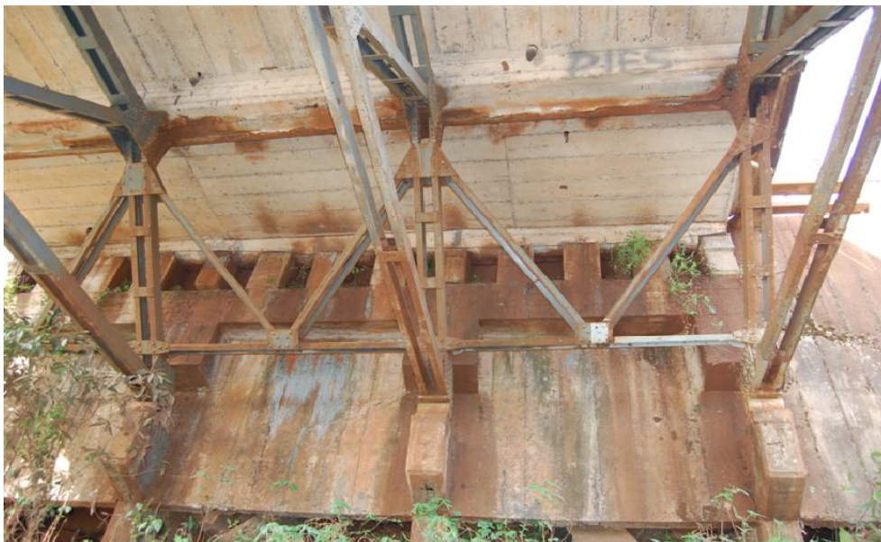
Figura 2.11: Vista del estribo.
