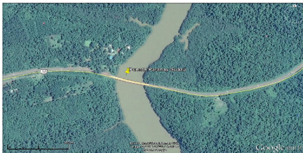
Figura 2.2: Fotografía satelital de Google Earth, ubicación del puente ampliada.
