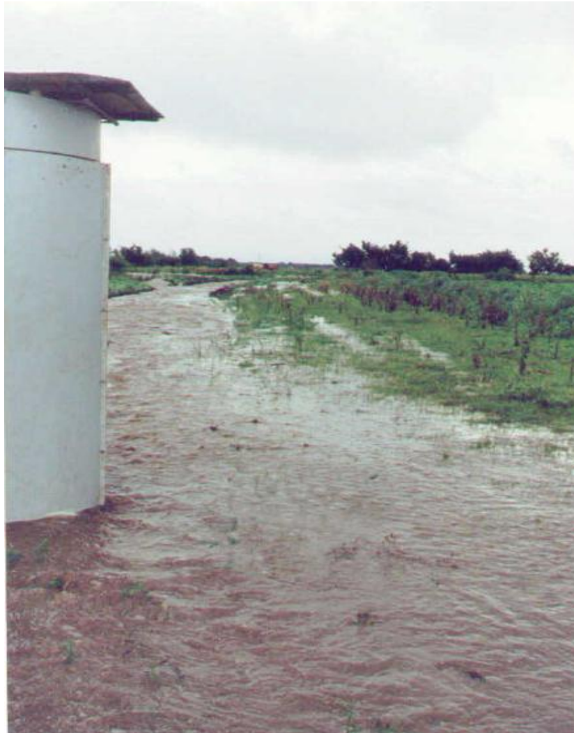
Figura II.29- Limnógrafo y canal de desagüe de Cuenca Grande
