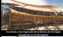
Encofrado y hormigonado de la lámina de hormigón armado de 12 cm de espesor
