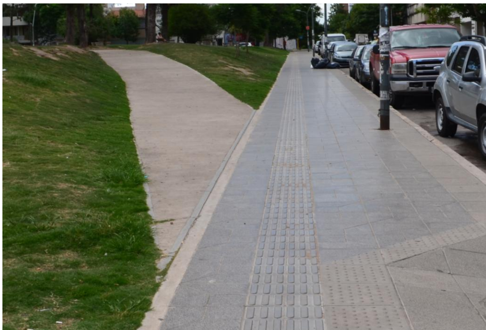
Figura 37: Vereda De Hormigón Peinado Existente en Paseo de las Tejas
