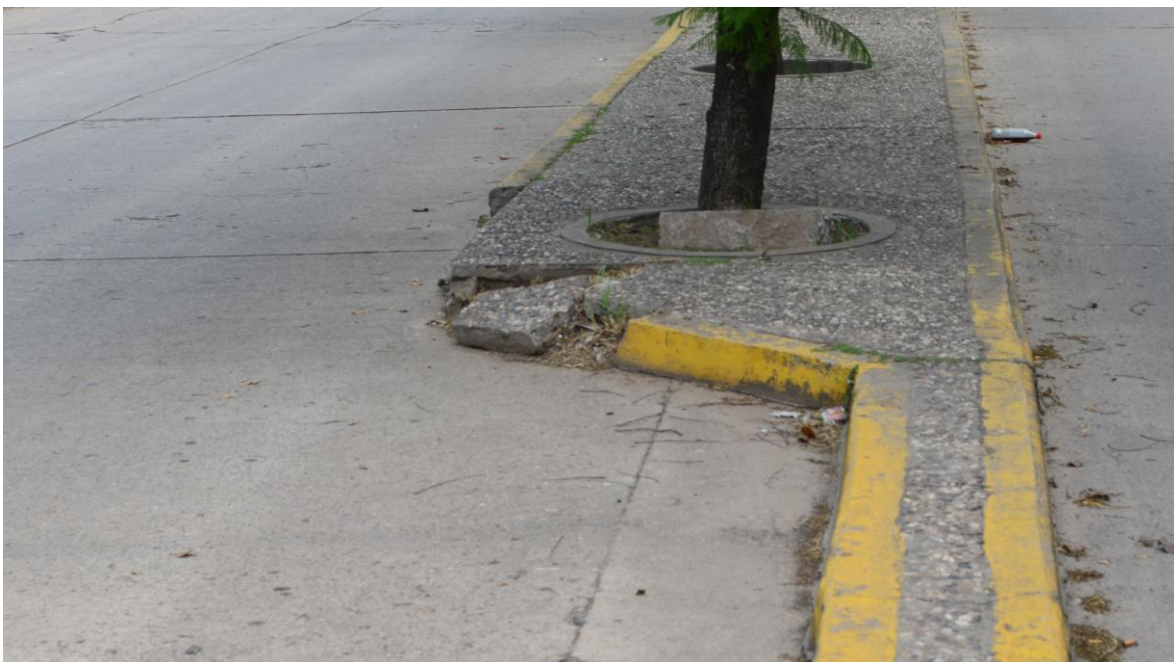
Figura 44: Cordones cuneta existentes
