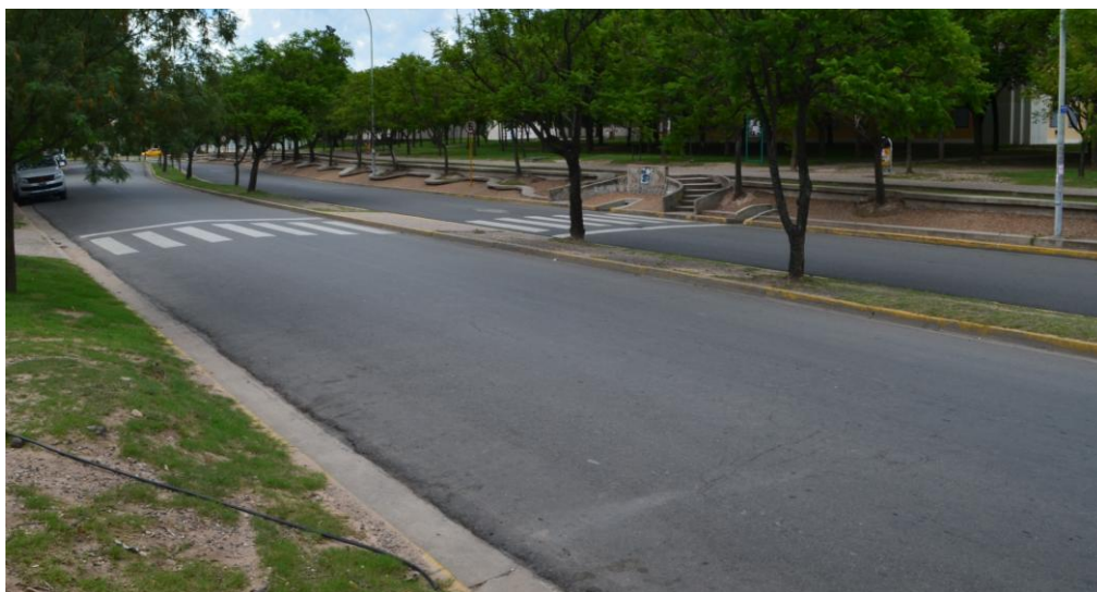
Figura 43: Área de Fresado y Demolición parcial
