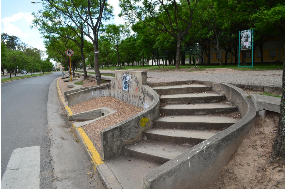
Figura 50: Escalera actual frente FAUDI
