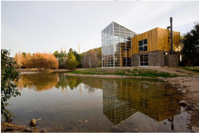
Figs. 17 y 18 – Casa Beamonte, Río Cuarto, Córdoba, 2009
